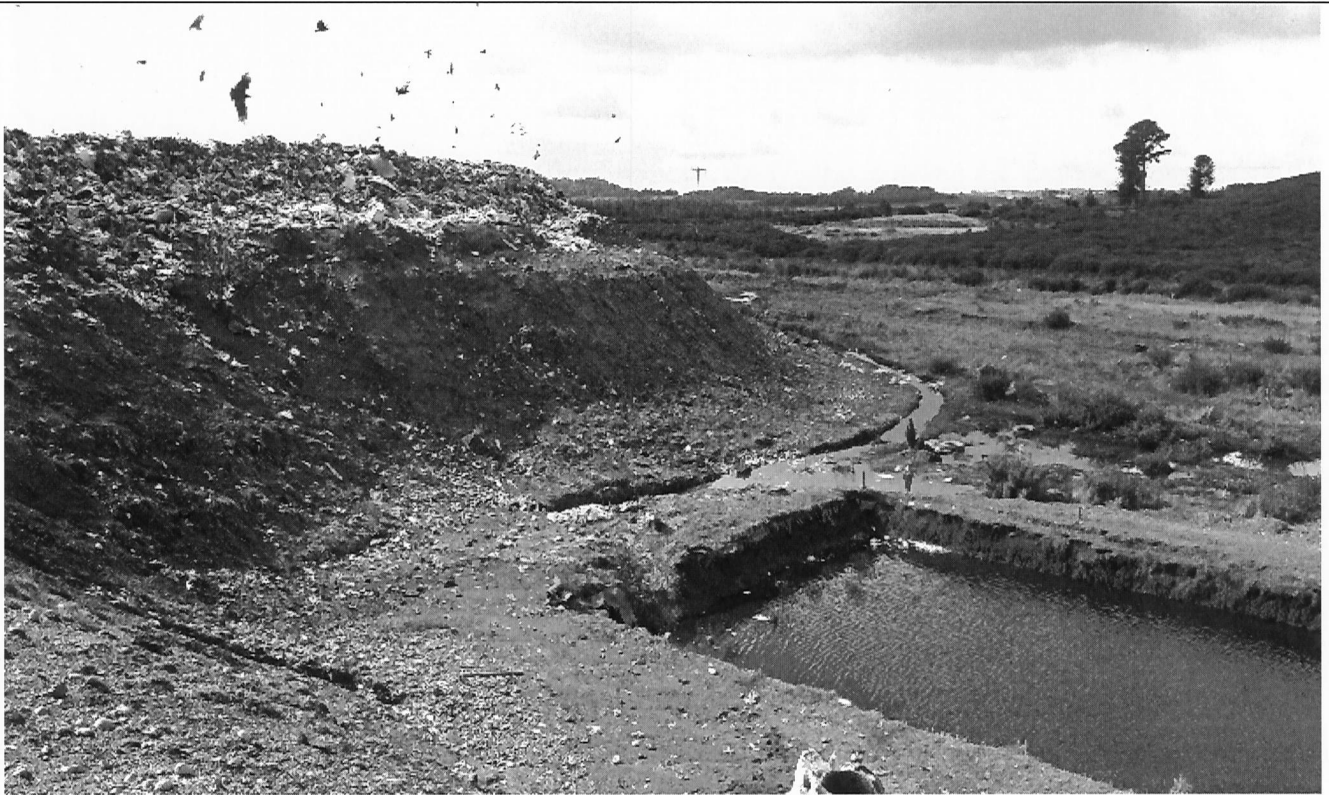
Fotografía N°3: Se observa escurrimiento de lixiviados provenientes de los residuos sin cobertura, con escurrimiento hacia la piscina de lixiviados no impermeabilizada, y hacia sectores cercanos a esta.
