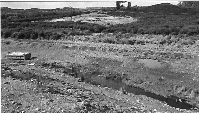
Fotografía N°4: Se constata presencia de lixiviados en zonas aledañas al canal de aguas lluvias.
