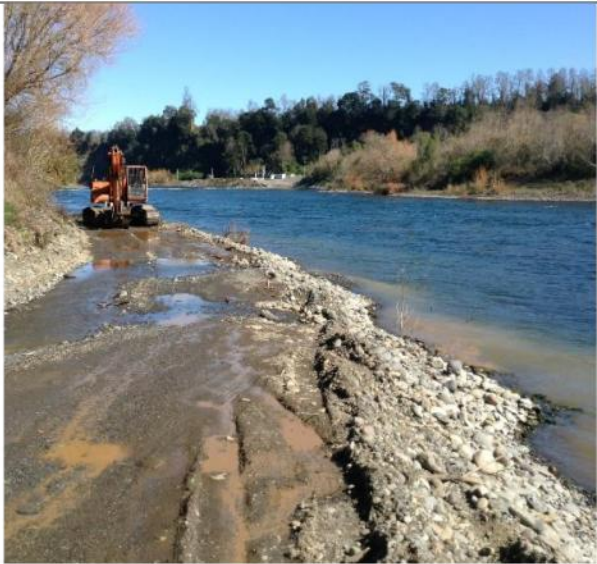
Fotografía N°1: Sector de inicio del “terraplen” (pretil) en proceso de remoción por parte del titular D&S. (Inspección 31.08.2020)
