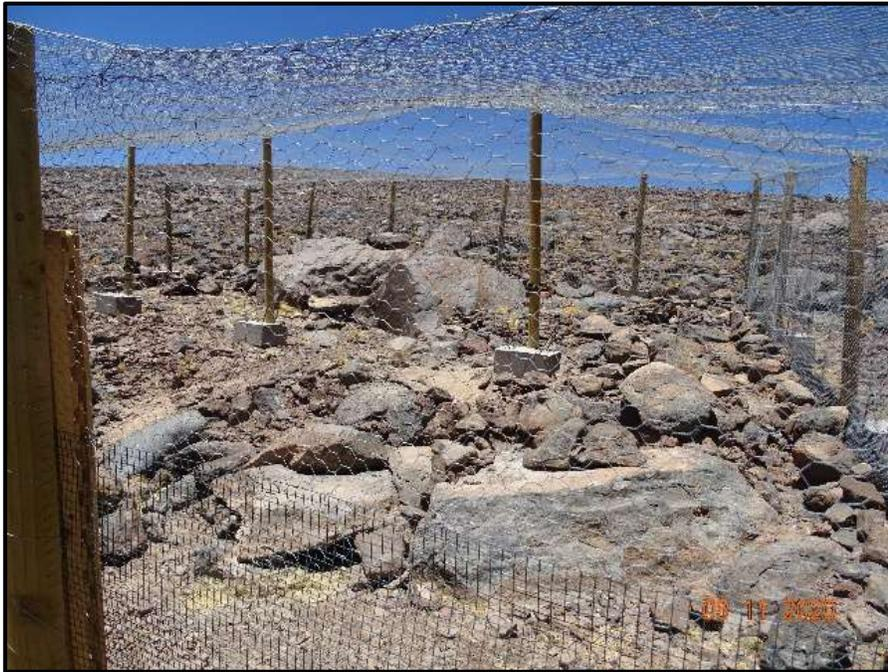
**Figura 10.** Vista interior del sitio SR02, se observa la malla hexagonal en techos y paredes con la presencia de pilotes que la sostienen.
