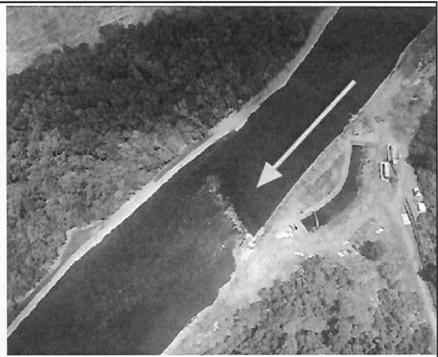
Imagen N° 2: Vista aérea (fecha desconocida) del maxisacos instalados en el río Rahue (Fuente: MMA).
