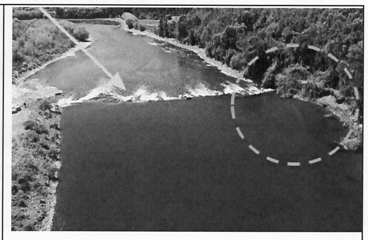
Imagen N° 10: Vista del pretil transversal. Se constata que en la ribera aladaña y previo al pretil, que el borde del río se encuentra en proceso de desmoronamiento ( Fuente: Inspección 22 de octubre de 2020).
