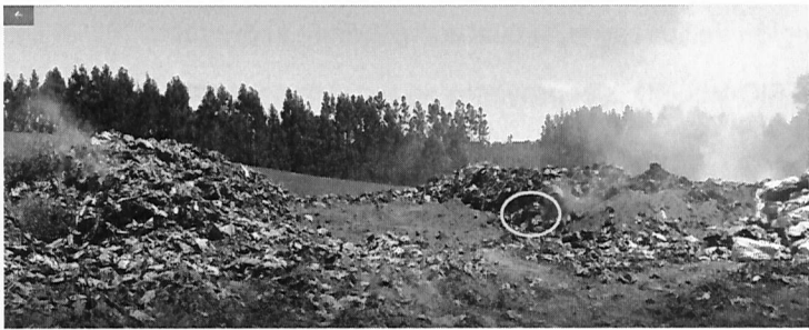
Fotografía N°6: Circulo amarillo destaca área con fuego.
