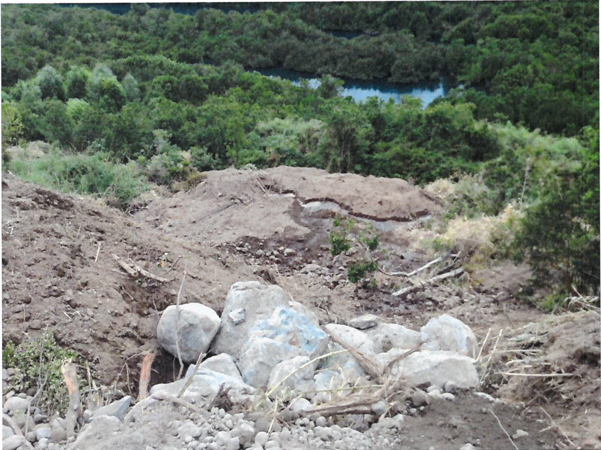
Fotografía 7. Se observa intervención de bosque nativo en pendiente de la ladera, con evidente riesgo de deslizamiento, al fondo río Maullín (24-12-2020).
