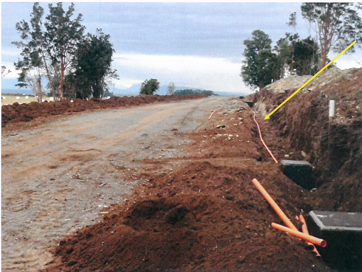
Fotografía 1. Trazado subterráneo de la electricidad del proyecto “Loteo Alto Maullín” (24-12-2020).
