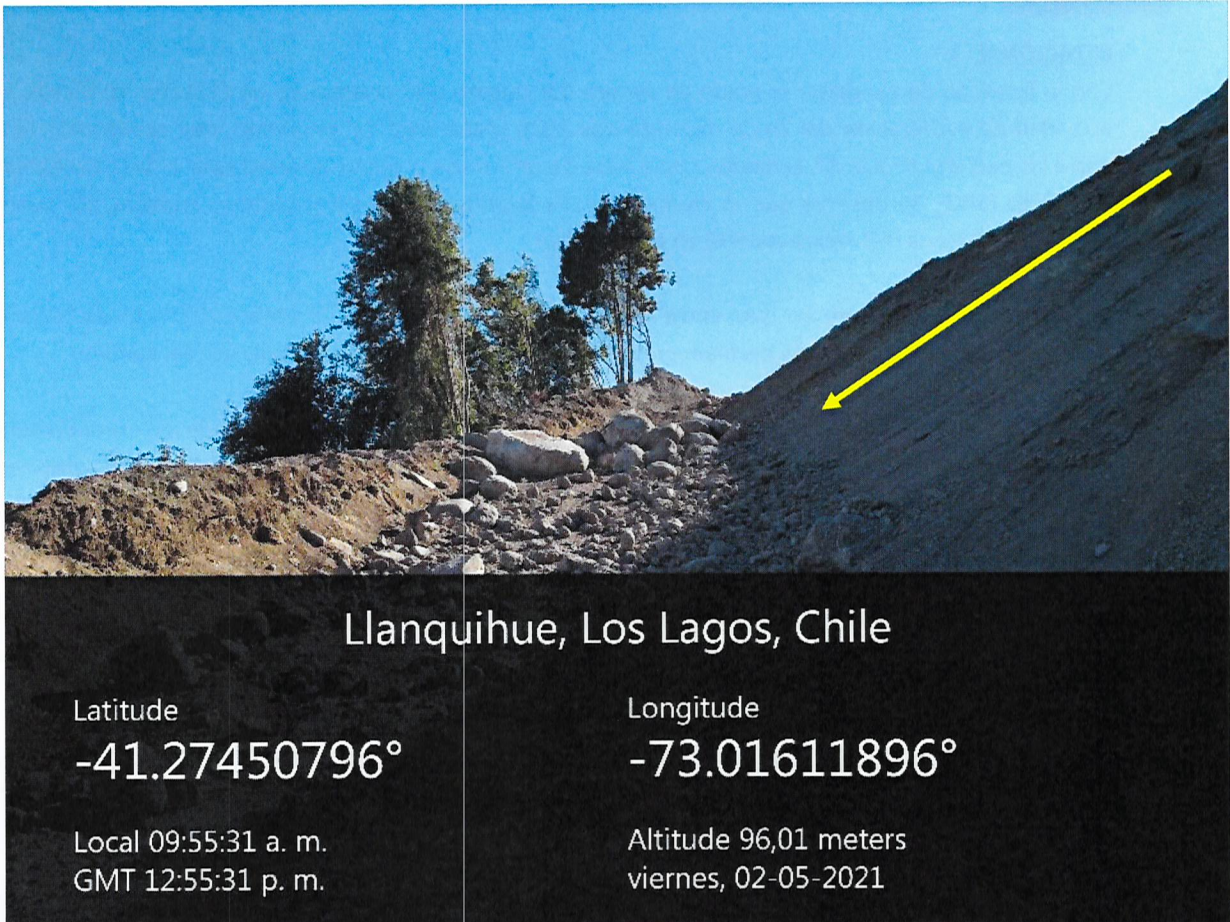
Fotografía 9. Obsérvese el reperfilamiento del talud de la zona intervenida respecto a fotografías 4, 5 y 6 del 24 de diciembre de 2020.
