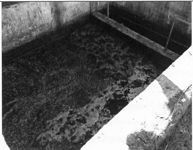
Fotografía N°4: Ril efluente (tratado) que luego se descarga para infiltración en predio colindante. Se observa ril de color oscuro, con aspecto anóxico, con burbujas y lodo sobrenadante.
