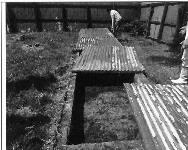
Fotografía N°3: Cámara de decantación del ril efluente, ubicada en zona colindante al matadero, de propiedad del titular.
