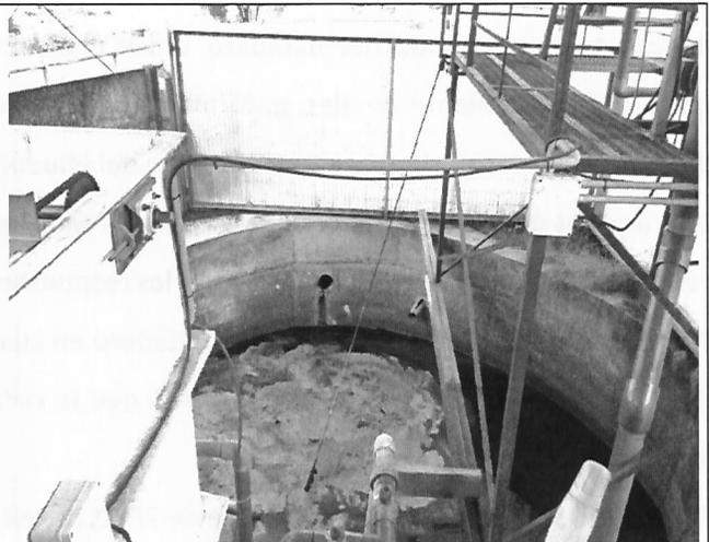
Fotografía N°2: Pozo de acumulación de ril afluente luego del filtrado de residuos sólidos, y cuya capacidad es de 10.000 lt.
