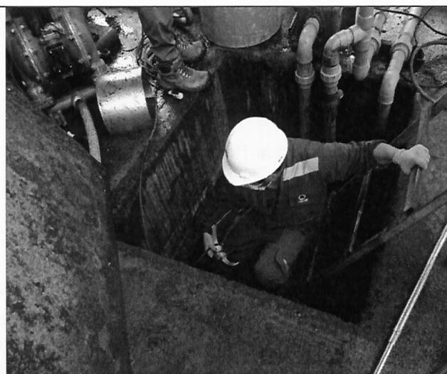
Fotografía N°5: Instalación de caudalímetro en tubo de descarga de ril afluente.
