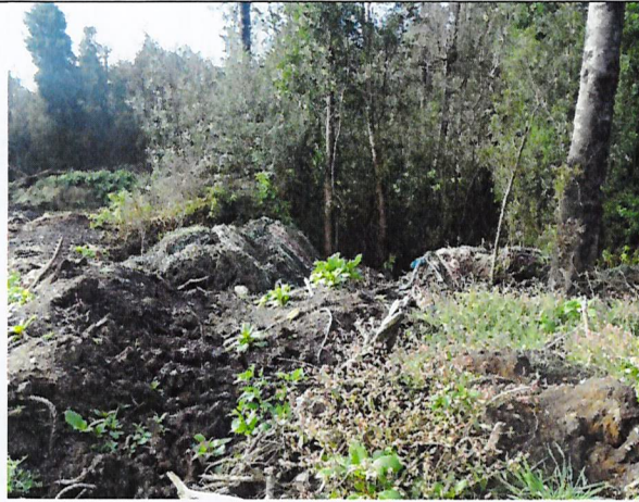
Fotografía N°10: Se observa redes enterradas en sector oculto tras pretil de tierra ubicado a un costado de pozo descrito en fotografía N°8.
