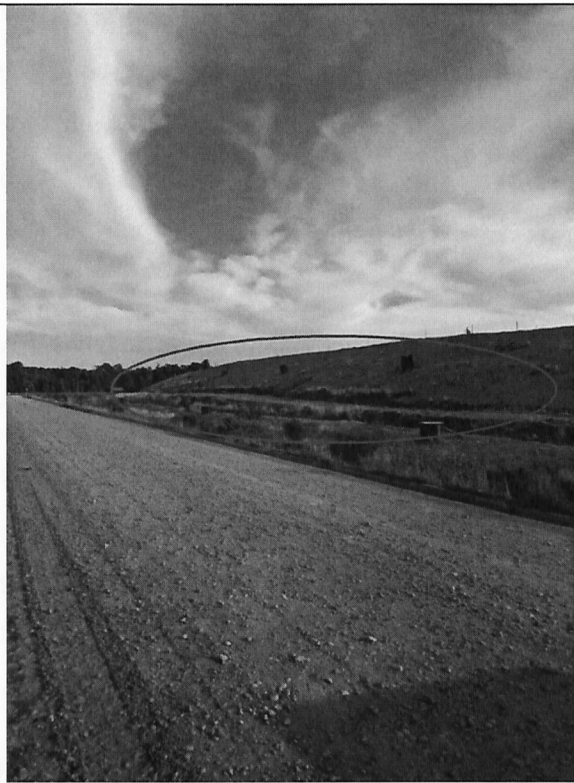
Fotografía N°1: Chimeneas con quemadores en el lado este del relleno sanitario
