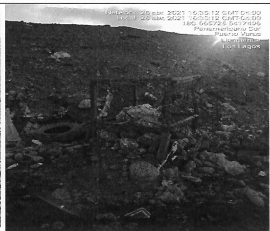
Fotografía N°4: chimenea sin quemador en el lado norte del relleno sanitario.
