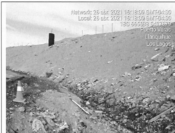
Fotografía N°3: chimenea con quemador ubicado en el lado este del relleno sanitario
