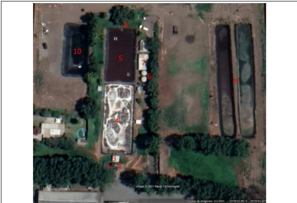
Figura 3. Componentes de la planta de tratamiento de residuos líquidos de Maltexco S.A.
