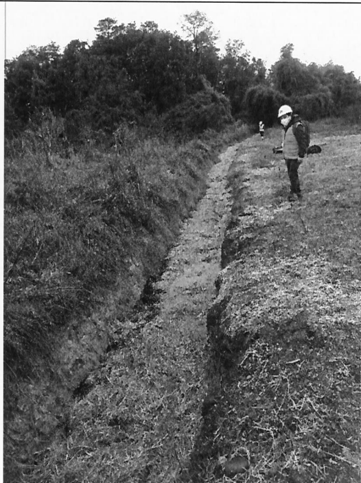
Fotografía N°15: Se constata canalización con lixiviados ubicada fuera del área del proyecto.
