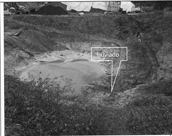
Fotografía N°11: Se observa pozo Sur de absorción de aguas lluvias. Se constata líquido oscuro (lixiviado) que llega al pozo.
