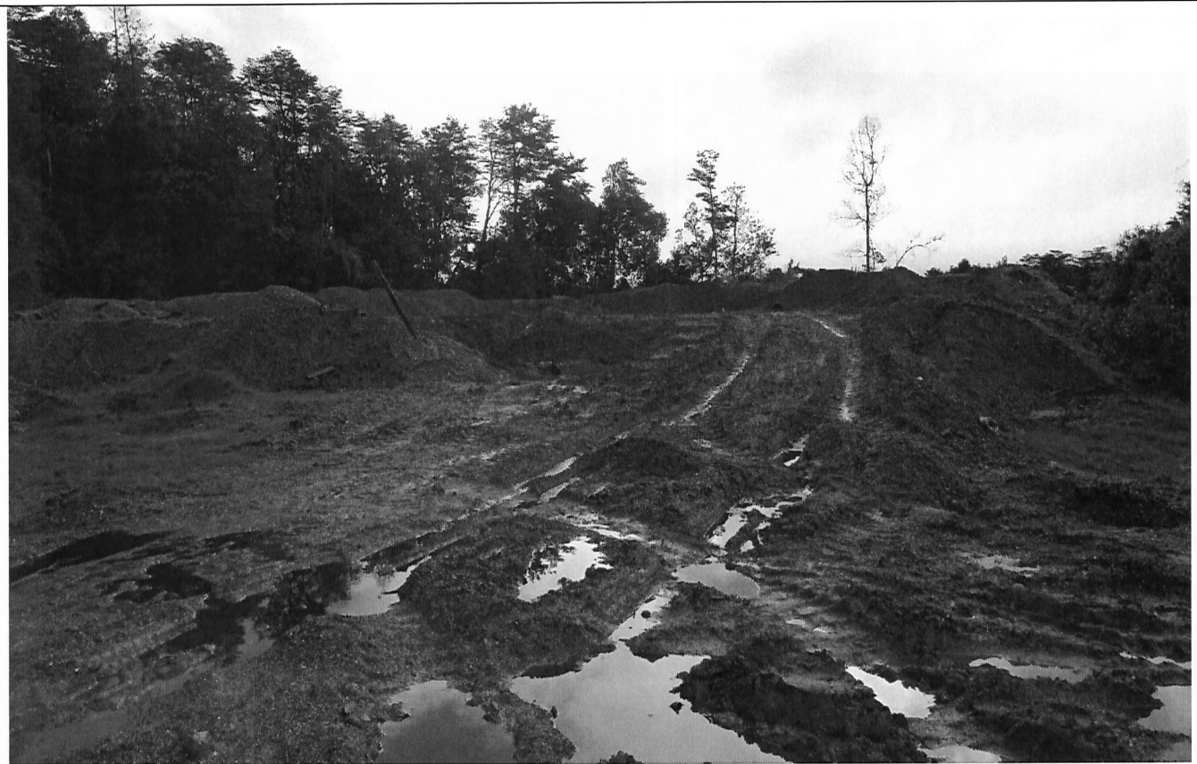
Fotografía N°21: Se observa acopio de conchilla por fuera del área del proyecto.
