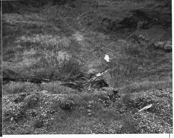
Fotografía N°12: Se observa pozo Norte de absorción de aguas lluvias. Se constata canalización con vertimiento de líquido oscuro proveniente de pila Noroeste.
