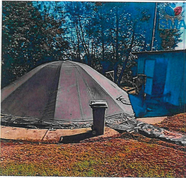
Foto N° 1. Estación N° 1 pozo de acumulación recria, fotografía muestra que la unidad completamente sellada.
