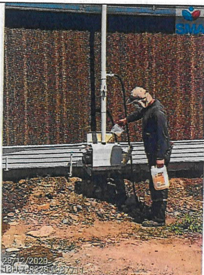
Foto N° 1 Aplicación Producto Aromático ventilación forzada sitio Mirador
