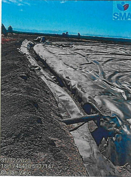
Foto N° 1 Cobertura superior sobre Digestor Primario N° 2
