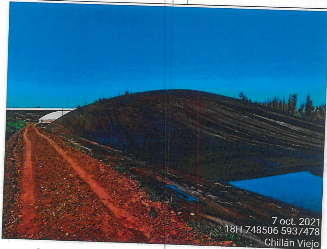
Foto N° 7. Estación N° 5 lagunas de acumulación de Digestato con acumulación de biogas.
