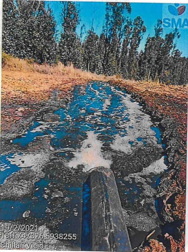
Foto N° 3 Otra vista de Salida de Digestato en zona de fertirriego
