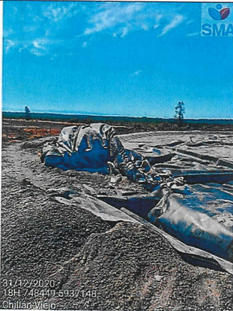
Foto N° 3 Agitador N° 2 Digestor primario N° 2 Aislado provisoriamente lámina superior mismo digestor.
