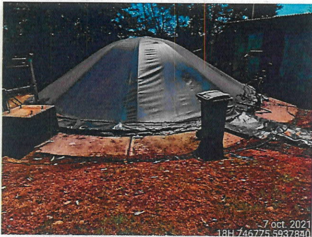
Foto N° 1. Estación N° 1 pozo de acumulación recría, fotografía muestra que la unidad completamente selladada.
