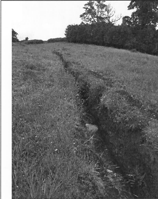
Fotografía N°9: Zanja construida por el titular, con pendiente para trasladar líquidos (RIL)
