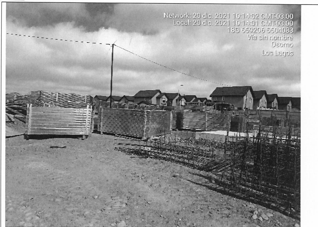
Fotografía N°2: zona de construcción de viviendas de la 4ta etapa condominio Tierra Noble.
