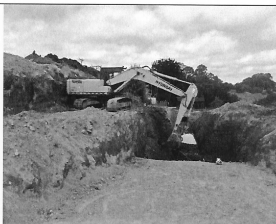
Fotografía N°6: Retroexcavadora operando en zona destinada a servidumbre de paso, la cual es parte del humedal Las Quemadas.
