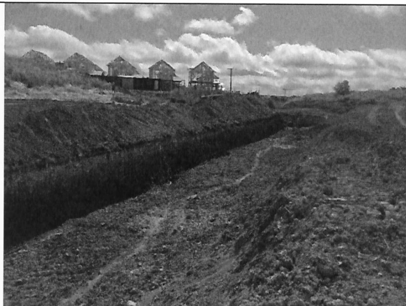
Fotografía N°5: corresponde a la zona intervenida sector según proyecto Socovesa para desarrollar la canalización de aguas lluvias de la totalidad de las casas de los condominios Tierra Noble I y II. Sector intervenido que es parte del Humedal Las Quemadas.
