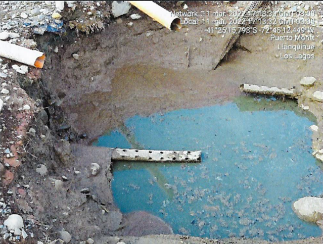
Fotografía N°34: Punto de filtración (P1), se observa saturación del sector, liquido verde, choritos sobrenadante y una capa espesa en la superficie de color café rojizo. Tiene tuberías perforadas bajo el nivel del suelo y dos tuberías sobre el nivel del suelo.
