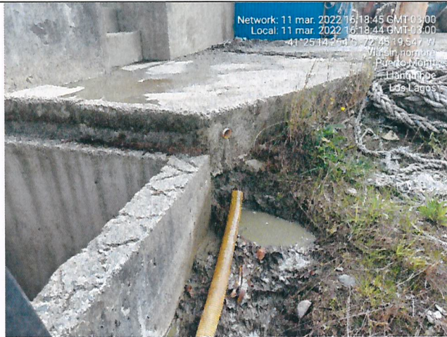
Fotografía N° 29: Se observa ril (líquido de color verde) proveniente de la zona de desinfección.
