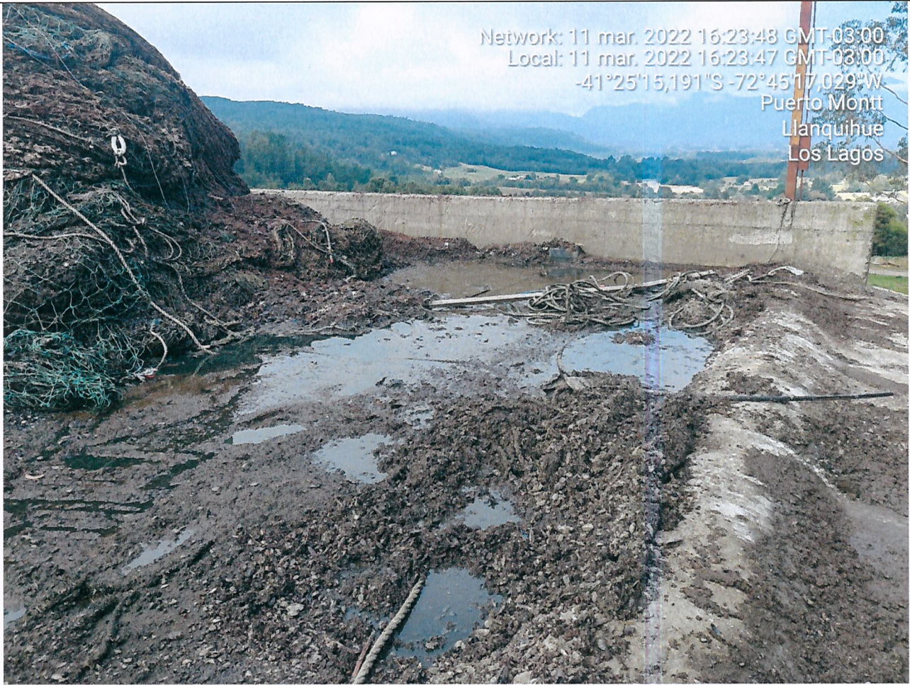
Fotografía N°1: Imagen permite constatar material orgánico fuera del pretil y aposamiento de lixiviados.
