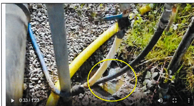
Fotografía N°25: RIL aposado en zona de llaves que permite direccionar ril tratado hacia los geocontenedores o filtro prensa.
