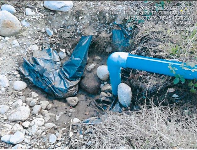
Fotografía N°35: Se observa un segundo punto de infiltración, en este punto se observa sobre saturación del suelo.
