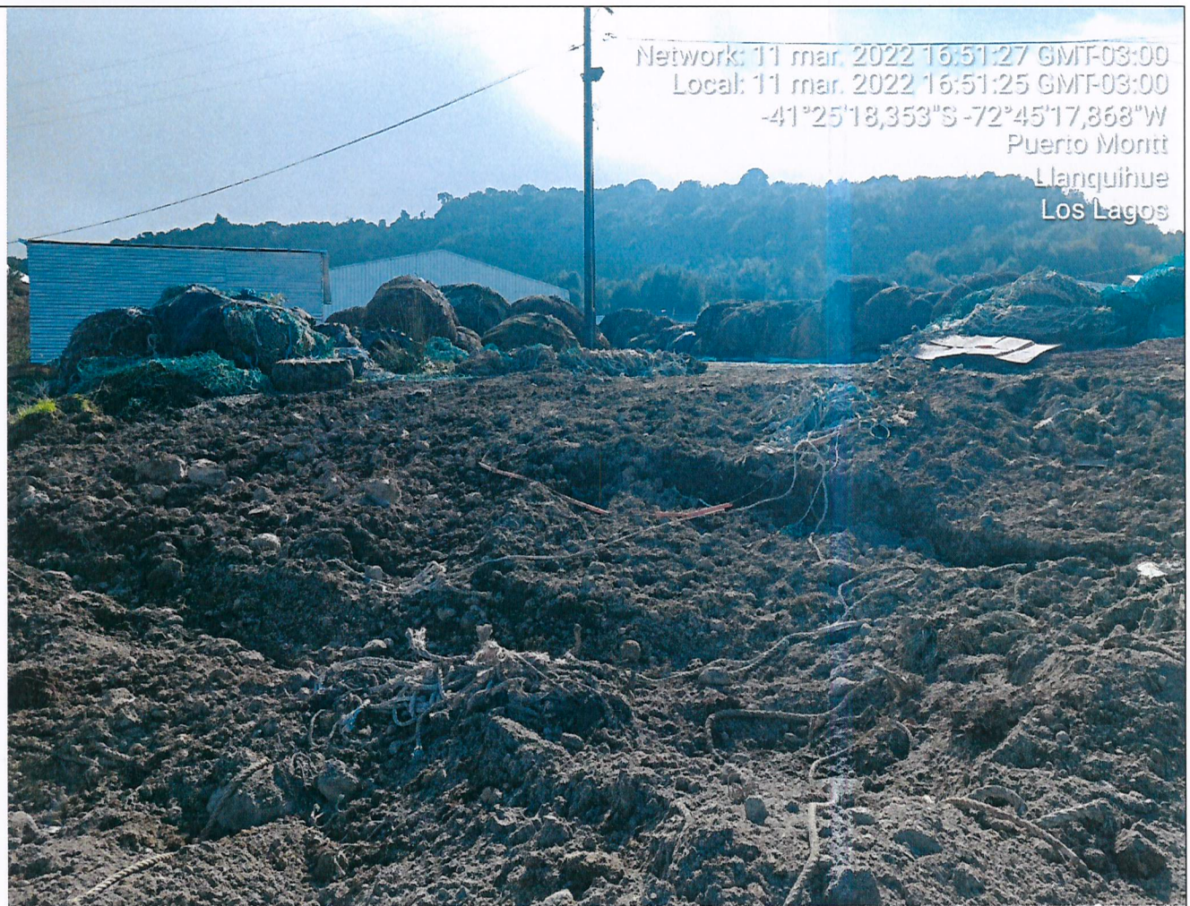
Fotografía N°3: Zona de disposición de lodos, cabos y residuos varios. La imagen permite observar el movimiento de tierra reciente, material no compactado.
