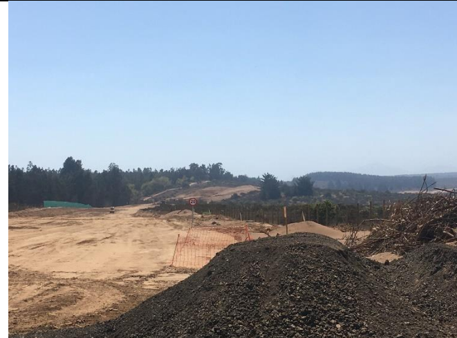
Fotografía 23. (Fuente: Inspección ambiental SMA 01-03-2022) Descripción: Vista hacia el norte del avance de las obras en la sección 2 (By Pass Puchuncaví) con material removito y vegetación a los costados
