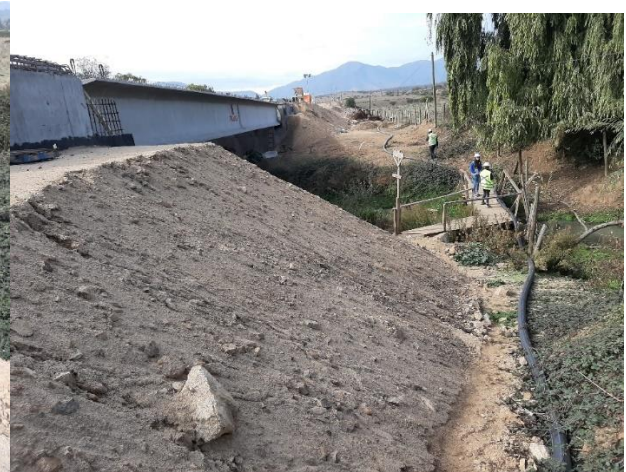
Fotografías N° 33 y 34: Nivel del relleno verificado en terreno, donde se aprecia nivelación de suelo compactado a costados de las obras, y con material deslizado sin contar con sistema de contención para resguardo del cauce del Estero Puchuncaví, donde se emplaza el Humedal urbano “Los Maitenes-Campiche”. (Fuente: Inspección ambiental SMA 20-05-2022)
