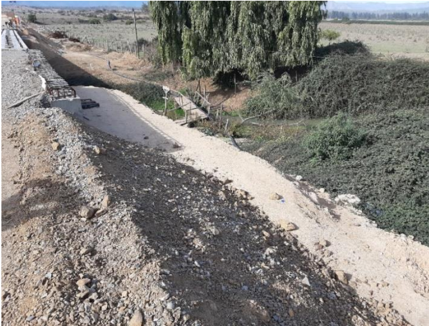
Fotografías N° 33 y 34: Nivel del relleno verificado en terreno, donde se aprecia nivelación de suelo compactado a costados de las obras, y con material deslizado sin contar con sistema de contención para resguardo del cauce del Estero Puchuncaví, donde se emplaza el Humedal urbano “Los Maitenes-Campiche”. (Fuente: Inspección ambiental SMA 20-05-2022)
