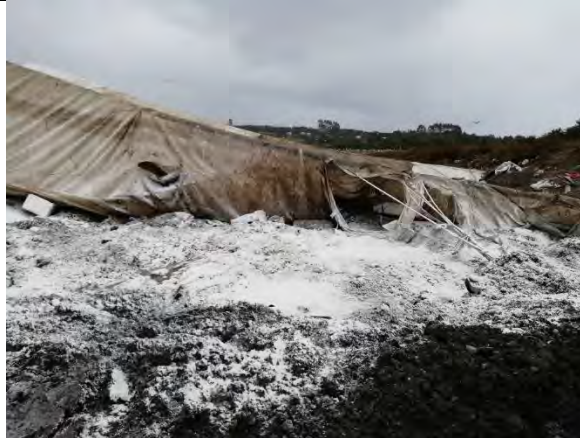
Imagen N° 18: Sistema impermeable estático implementado en zanja activa
