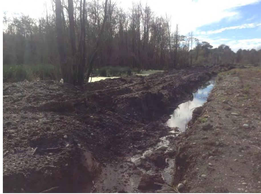
Imagen N° 43: Presencia de líquidos lixiviados en el sector norte colindante al Vertedero Dicham
