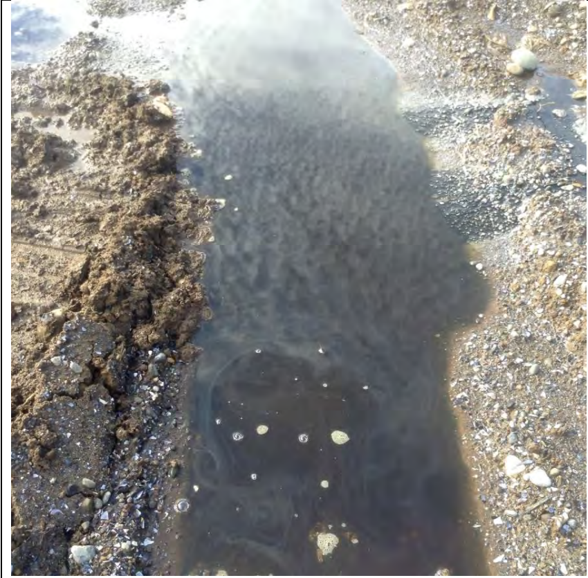
Imagen N° 45: Lixiviado aposado en la base de la torta en el sector Sur Oeste del Vertedero Dicham
