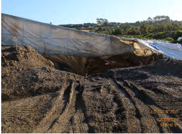
Imagen N° 17: Sistema impermeable estático implementado en zanja activa
