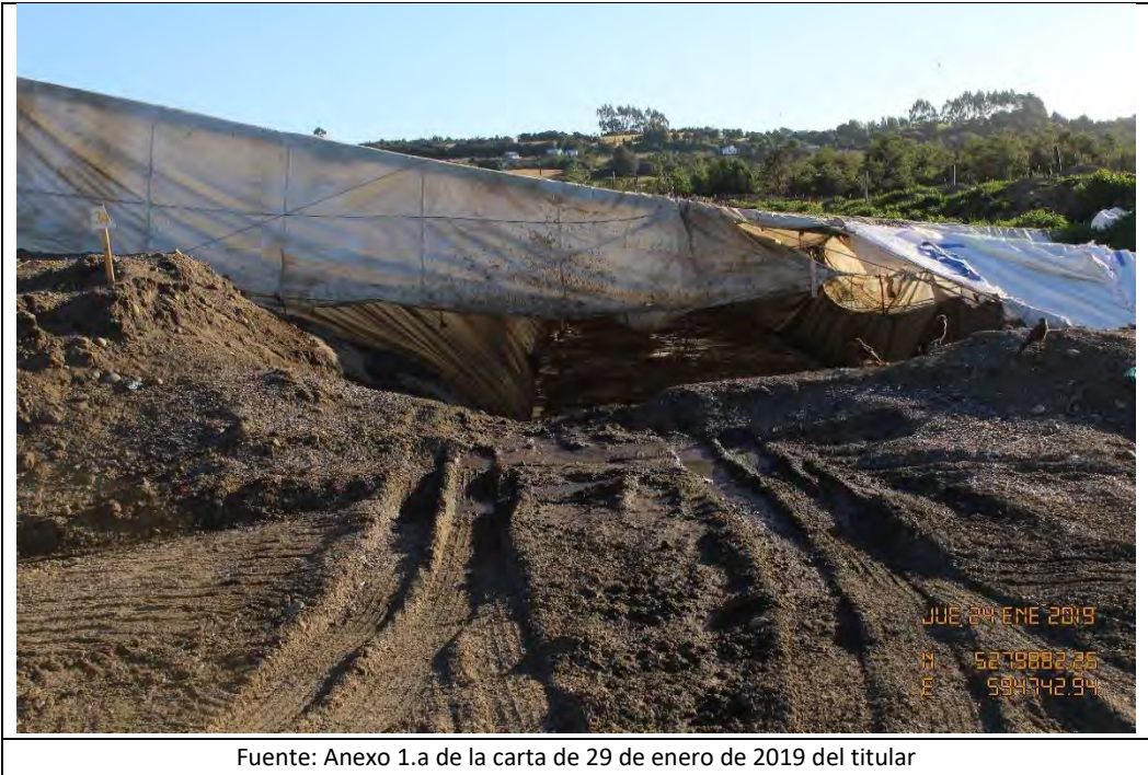
Imagen N° 37: Sistema impermeable sin pendiente requerida en zanja N° 34, se observan manchas que dan cuenta de la acumulación de agua
