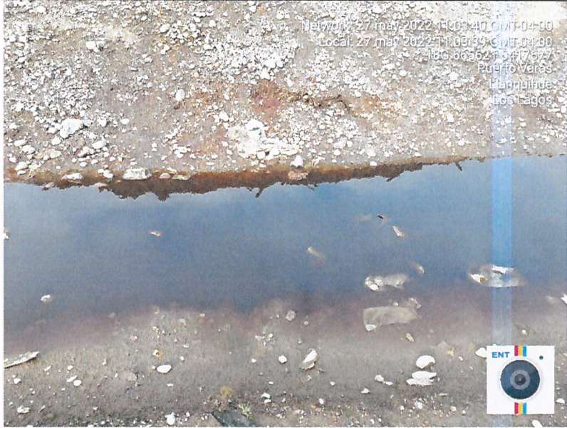
Fotografía N°6: cuneta del lado norte del alveolo 1 se constata agua lluvia mezclado con lixiviados y residuos.
