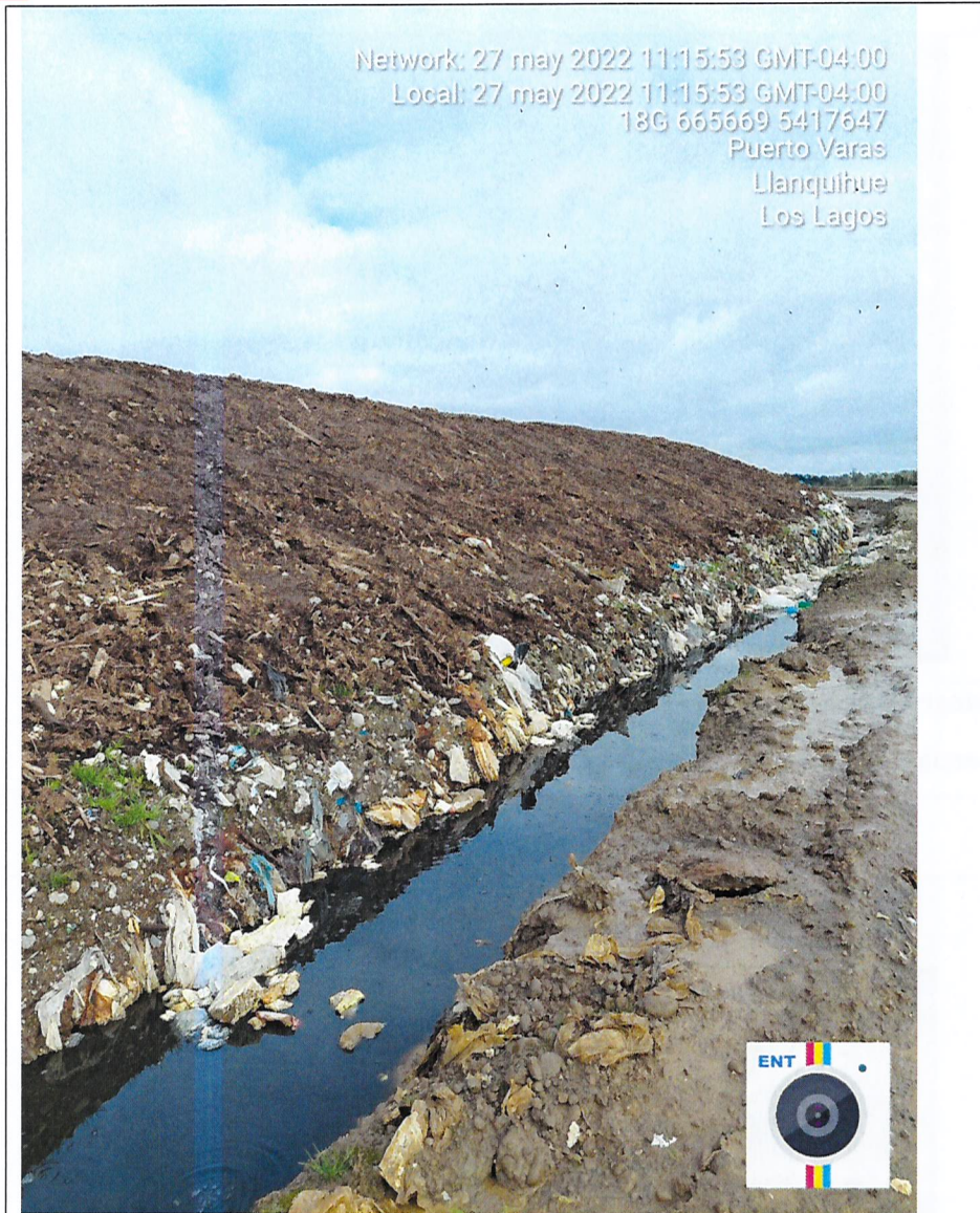
Fotografía N°8: cuneta del lado norte del alveolo 1 se constata agua lluvia mezclado con lixiviados y residuos.
