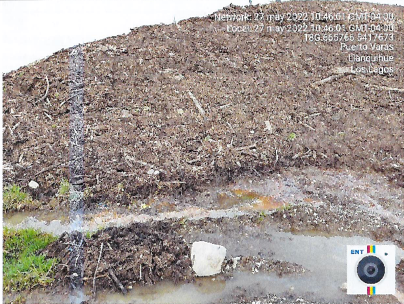
Fotografía N°4: Se observa en la esquina del lado Norte con el este del alveolo 1 escurrimiento de lixiviado.
