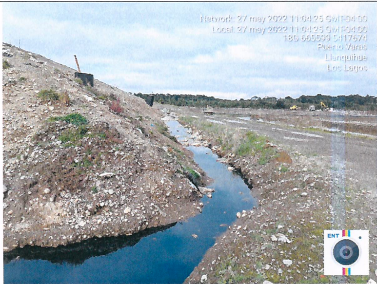
Fotografía N°7: cuneta del lado norte del alveolo 1 se constata agua lluvia mezclado con lixiviados y residuos.
