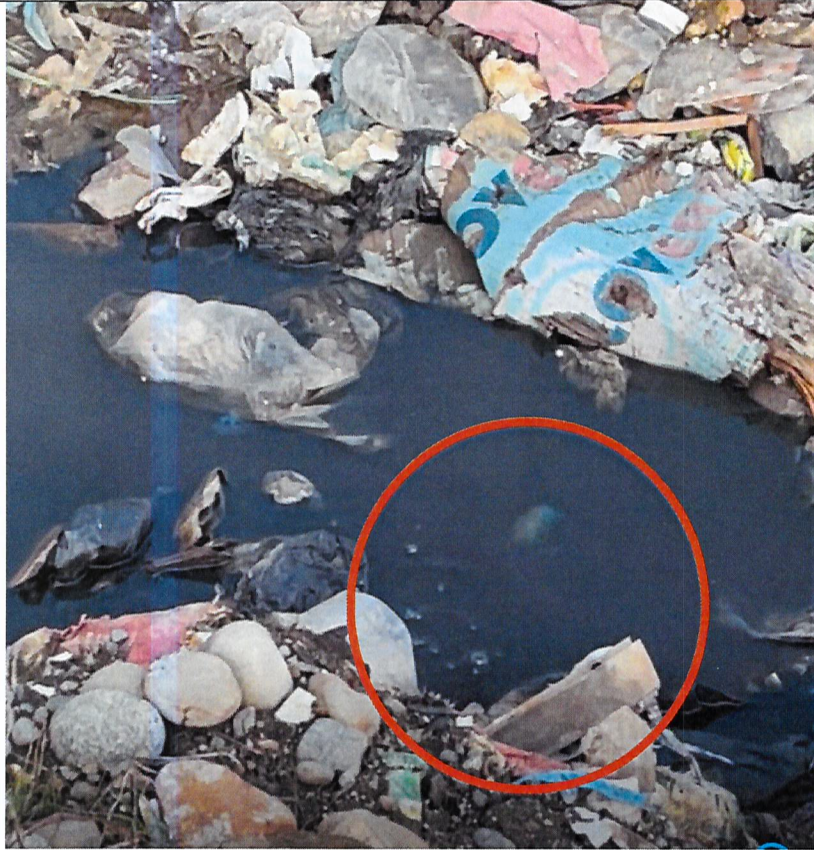
Fotografía N°10: cuneta del lado Sur del alveolo 1 se constata agua lluvia mezclado con lixiviados y residuos.
