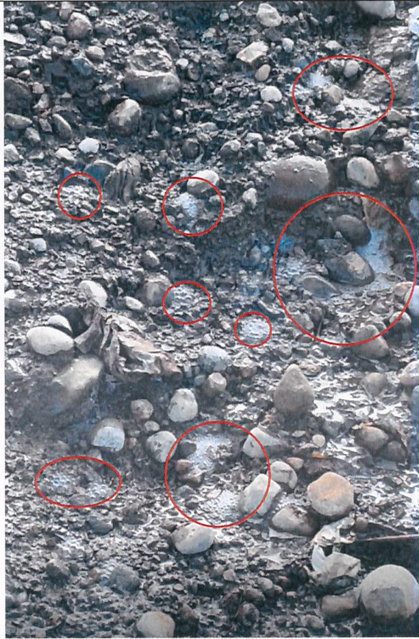
Fotografía N°11: Talud del lado Sur, se constató burbujeo, además se percibe un fuerte olor a gas.
