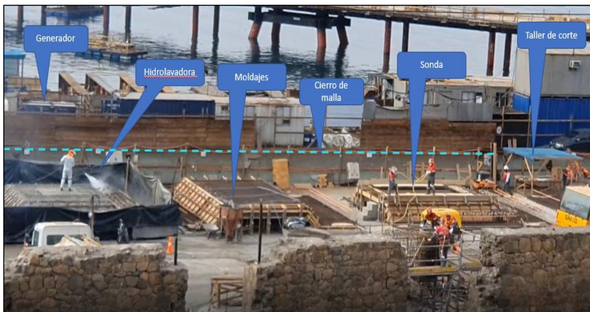
Foto 3: Vista desde casa de receptor de ruidos D2 hacia sector “Patio de Fabricación de Pilotes” con actividades y equipos utilizados en la construcción del proyecto. Se indica la localización de Cierro de Malla (línea punteada celeste) (Fuente: captura de imagen de video presentado en denuncia http://siden.sma.gob.cl/Denuncia/Ficha/26731 )
