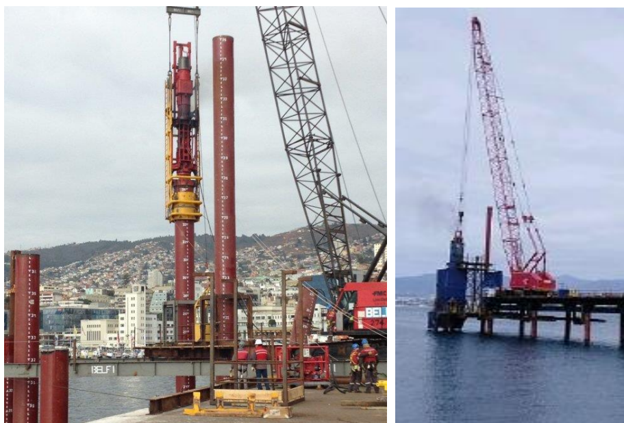
Figura 2: Equipos utilizados en faenas de hinca de pilotes.
