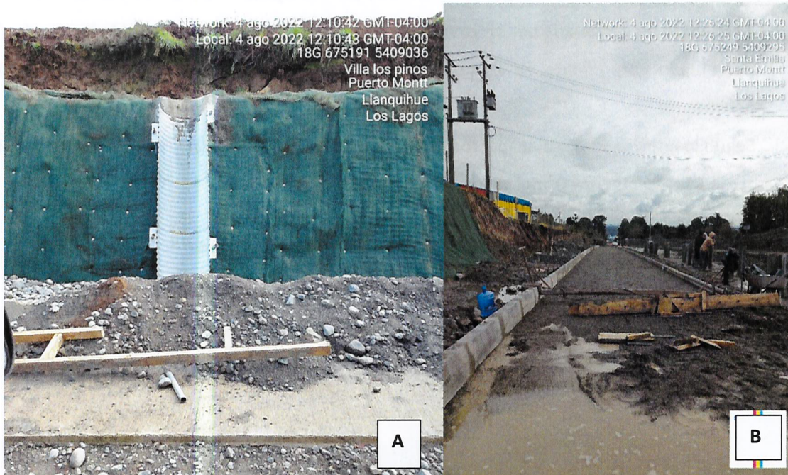
Fotografía N°10: A) Canaletas para aguas lluvias en “Avenida El Bosque”, sector poniente; B) Trabajos en “Avenida El Bosque”, que conecta a “Avenida Fourcade”
