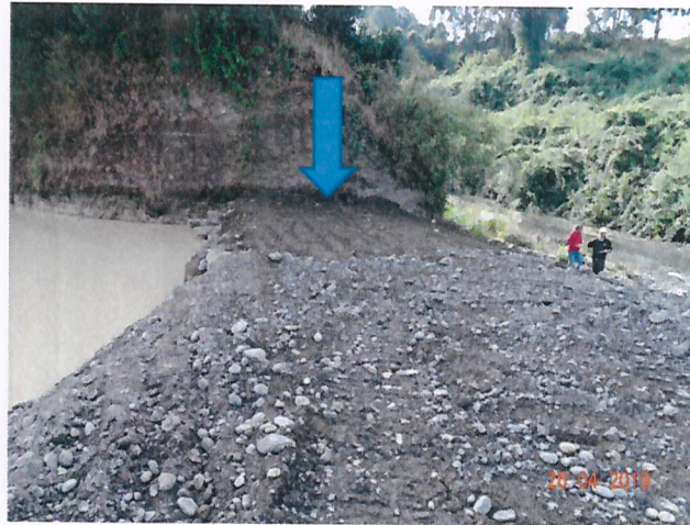
Imagen N°4: En la foto, labores de inspección de la SMA del 2019, que dan cuenta que el camino o pretil fue objeto de reparación con bolones y tierras, ello con el fin de evitar el escurrimiento hacia el estero Traiguén
