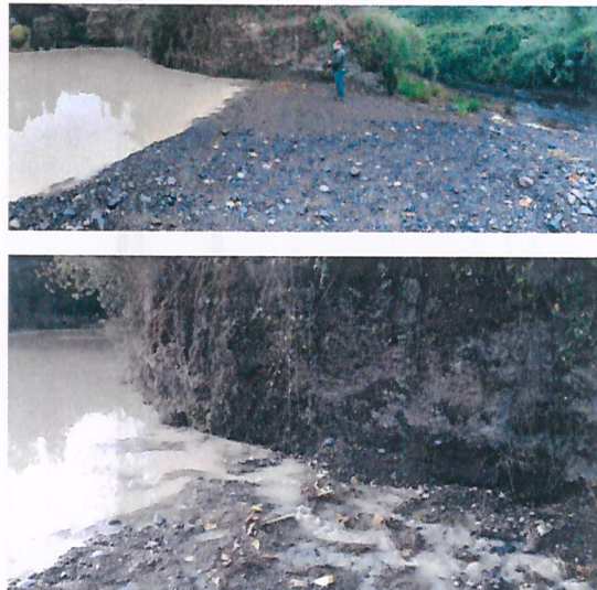
Imagen N°3: Imágenes de medios de comunicación de la contingencia del año 2019. En la foto se observa el rebalse del pozo N° 5, haciendo llegar alto sedimento al estero Traiguén que se observa al fondo de la fotografía.
