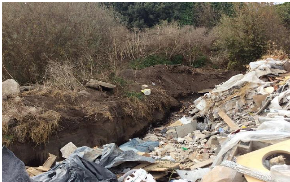
Imagen 1. Construcción de zanja y escarpe de terreno del humedal
