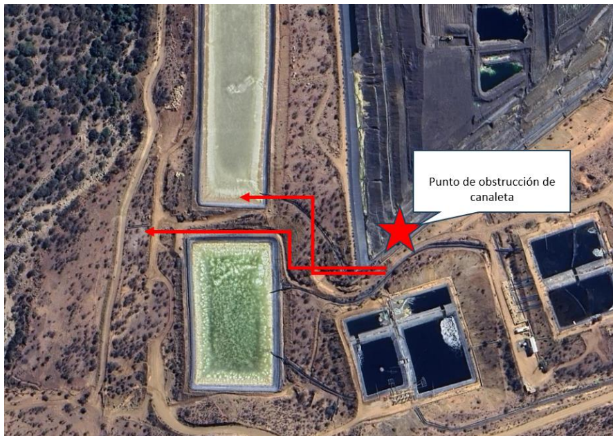
Figura N°2: Sector de pila de lixiviación donde se produjo el incidente. Fuente: Reporte del titular, incidente ID 1050635.
