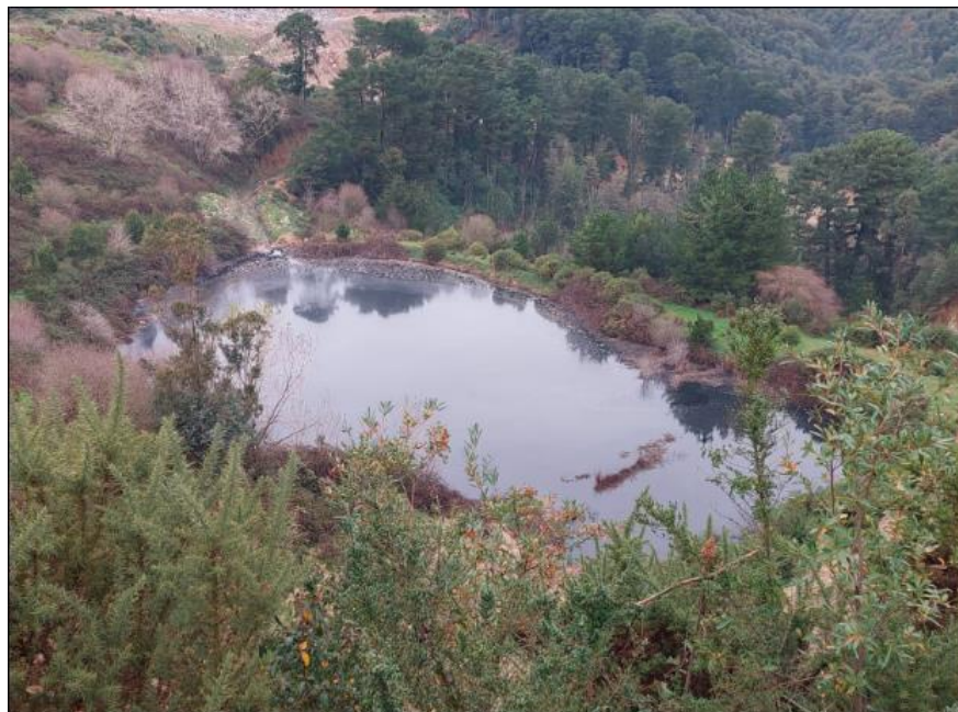
IMAGEN 2. LAGUNA DE LIXIVIADOS DEL VERTEDERO MOROMPULLI
