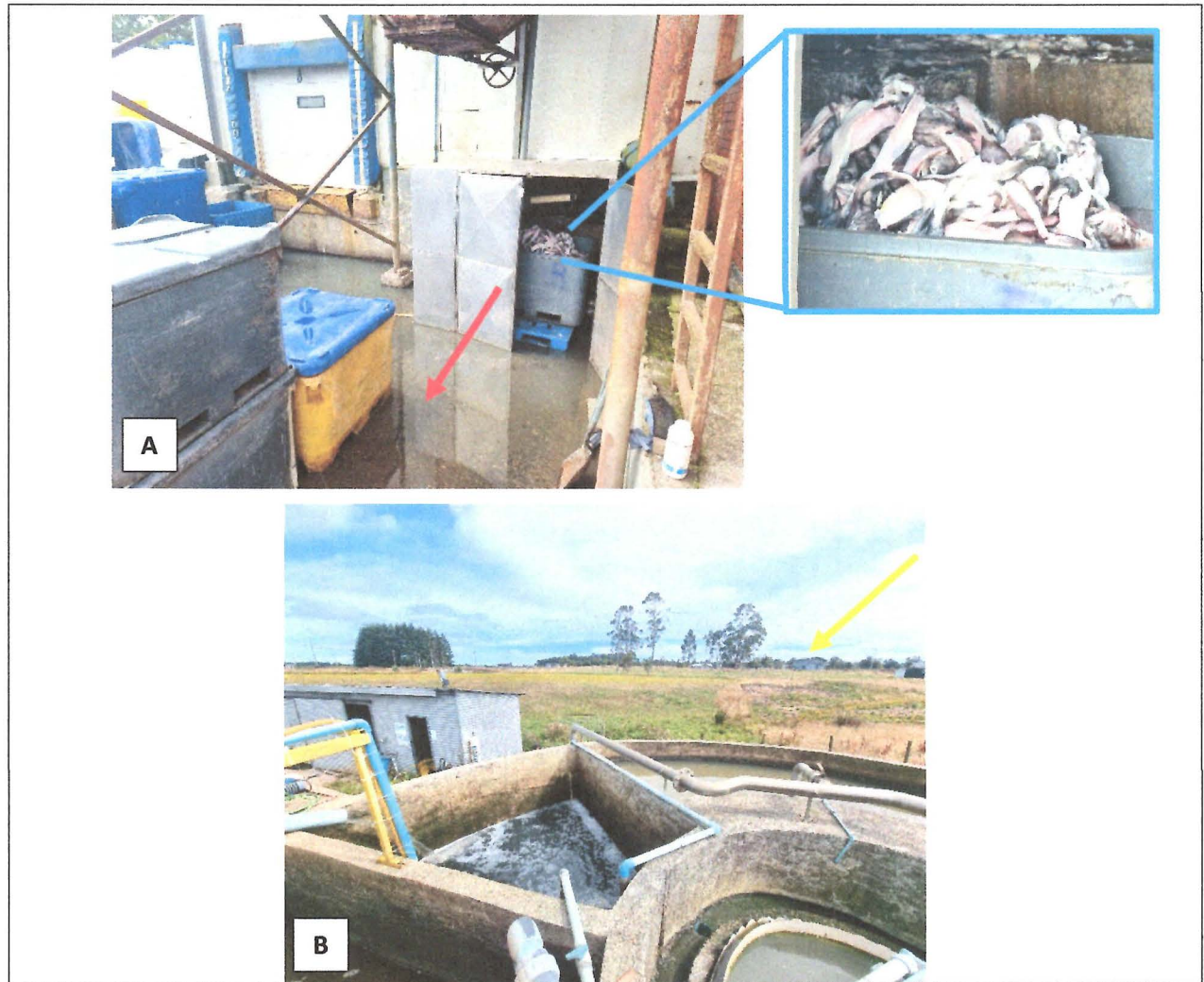
Fotografía 3. A) zona de acopio de bins con residuos de peces, mostrando acumulación de residuos líquidos en piso (flecha roja). B) Vista de sistema de tratamiento de Riles, y atrás las viviendas aledañas (flecha amarilla).
