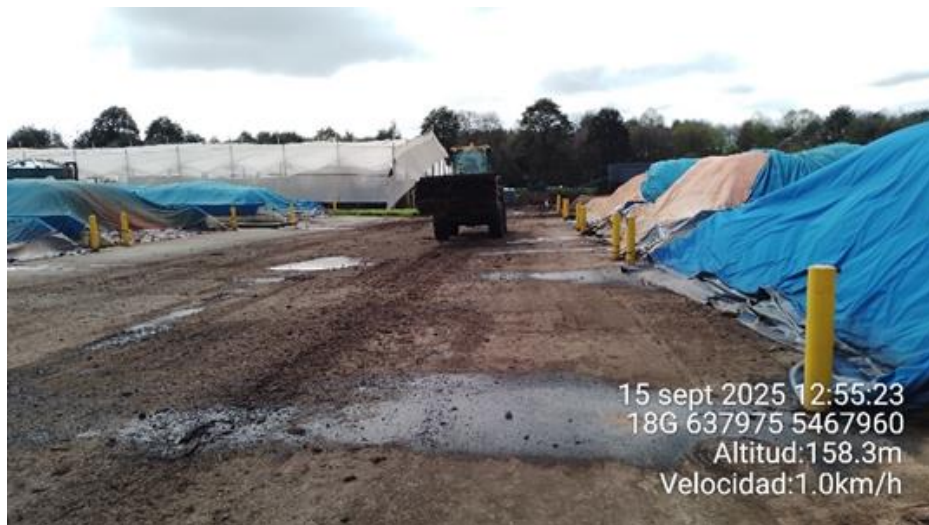
Imagen 6. Escurrimiento frontal de Lixiviado desde las trincheras hacia las rejillas para aguas lluvias ubicadas al centro del patio de las 12 trincheras de la Planta
