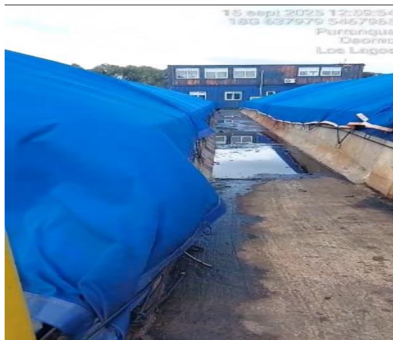
Imagen 7. Entre las Trincheras N°3 y N°4 se constata la presencia de líquido lixiviado mezclado con aguas lluvias.
