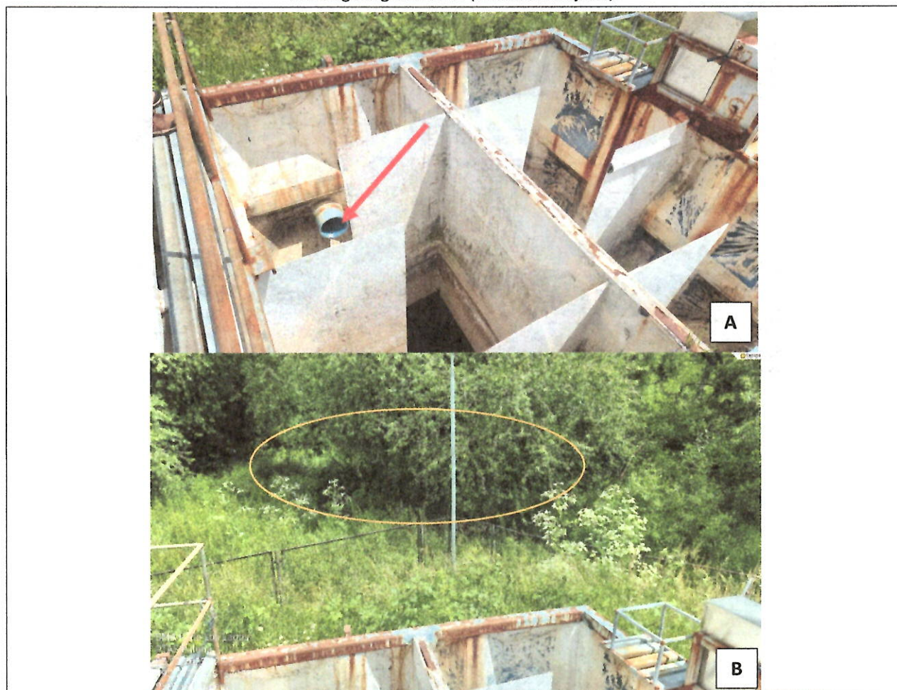
Fotografía 4. A) Cámara de contacto en desuso, con ducto de salida (flecha roja). B) Vista hacia zona de descarga según diseño (óvalo anaranjado).
