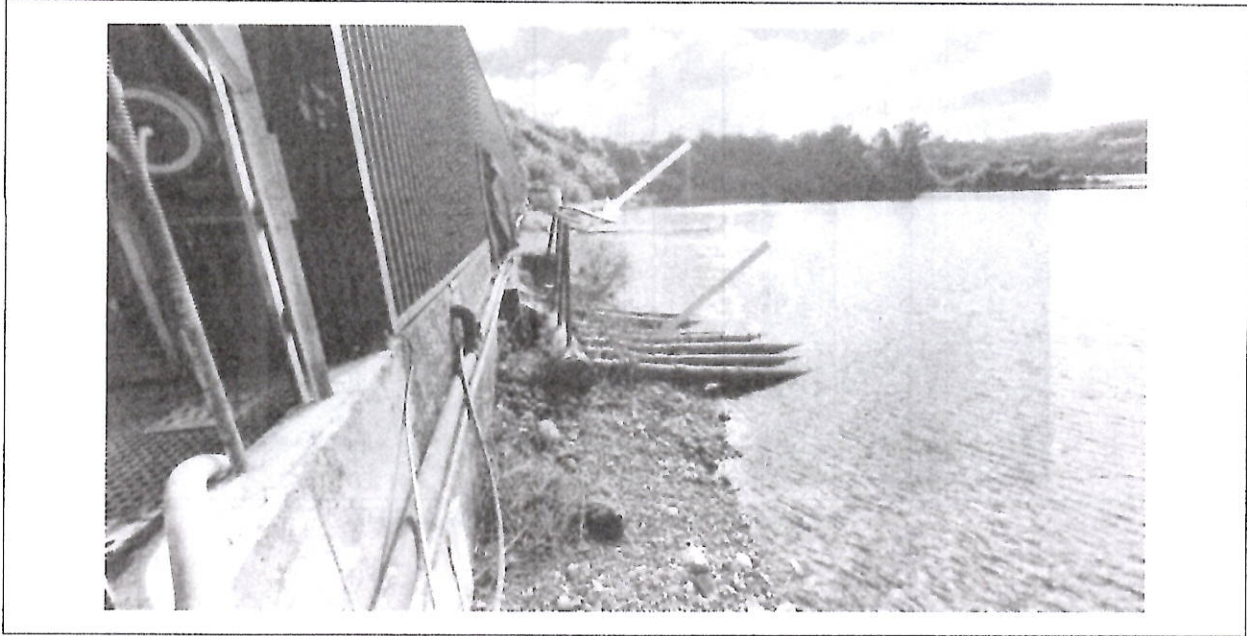
Fotografía 3. Ductos de descarga de efluente (flecha roja), y de succión de agua (flecha amarilla) en el Lago Llanquihue.
