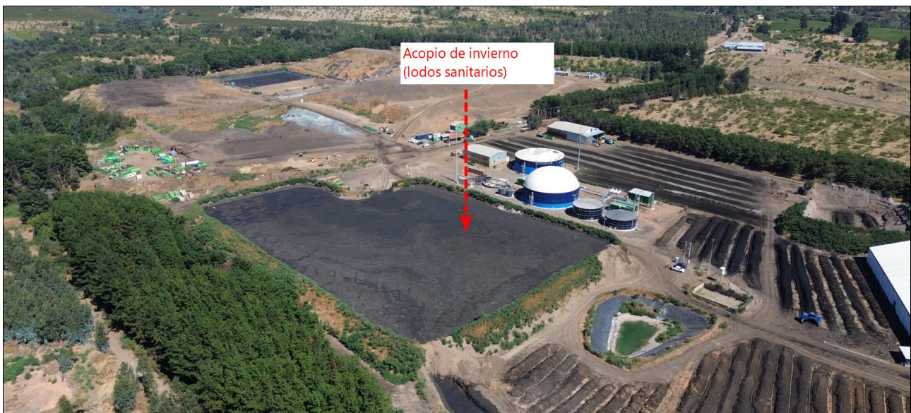
Figura 4. Fotografía aérea captada con DRONE el día 07-03-2026 donde se puede apreciar el denominado acopio de invierno de lodos sanitarios, obra no autorizada utilizada para gestión de residuos sanitarios.
