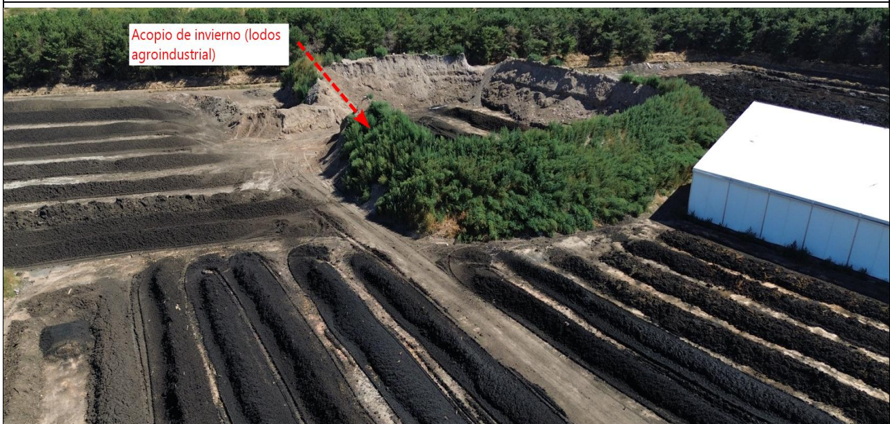
Figura 5. Fotografía aérea captada con DRONE el día 07-03-2026 donde se puede apreciar el denominado acopio de invierno de lodos agroindustriales. La obra se encuentra en su mayor parte vacía, y mantiene en la práctica los muros de contención.
