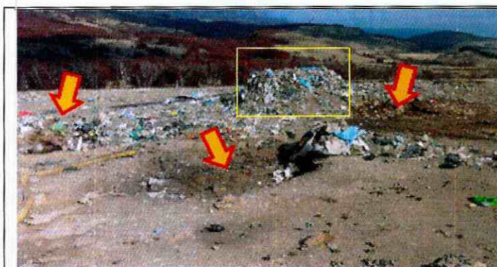
Fotografía N° 3: Tomada el 19 de mayo 2016. Vista general de la superficie de la celda. Las flechas indican las 3 excavaciones constatadas y el recuadro amarillo muestra un acopio de residuos sólidos sin cubrir, aparentemente provenientes de las excavaciones observadas.
