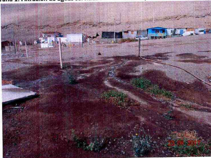
Fotografía 1: Filtración de aguas servidas sobre el terreno, al momento de la inspección
