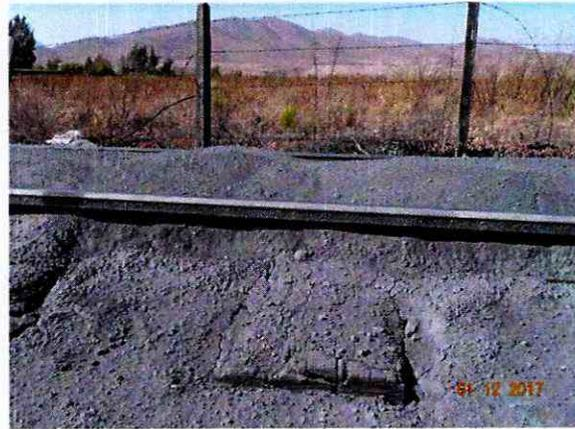
**Fotografía N° 13(izquierda):** Detalle de la presencia de concentrado derramado de hierro sobre la línea férrea en el sector de Huasco Bajo, donde la línea pasa en forma paralela a la Iglesia y espacio público (plaza) del sector (01.12.2017).
