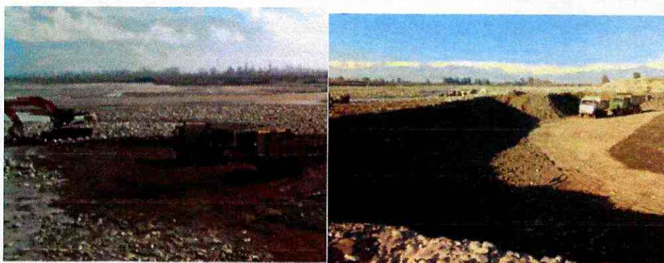
Imágenes N° 5 y N°6. Avance de faena de extracción de áridos constatada por la DGA: a) 30 de mayo de 2016., profundidad de extracción de 30 cm; b) 10 de junio de 2016. Profundidad de extracción de 3,5 metros. 6
