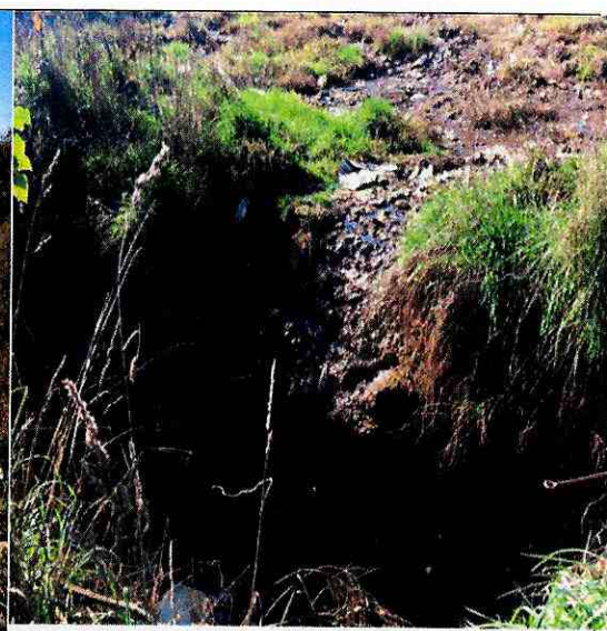
Fotografía N°14: Se observan líquidos lixiviados que escurren en el sector Oeste del Vertedero (sector de ingreso) hacia una zanja perimetral.
