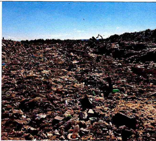
Fotografía N°5: Se observa que el camino (vía de acceso) al interior del vertedero se encuentra obstruido con residuos.
