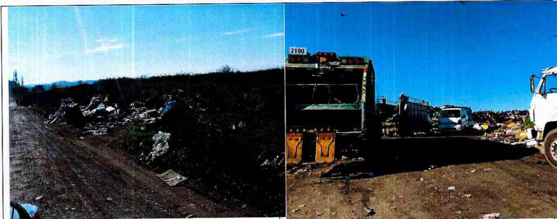
Fotografía N°1: Camino de acceso al Vertedero con residuos. Fotografía N°2: Se observan camiones municipales, y particulares dejando residuos en el camino de ingreso al interior del vertedero.
