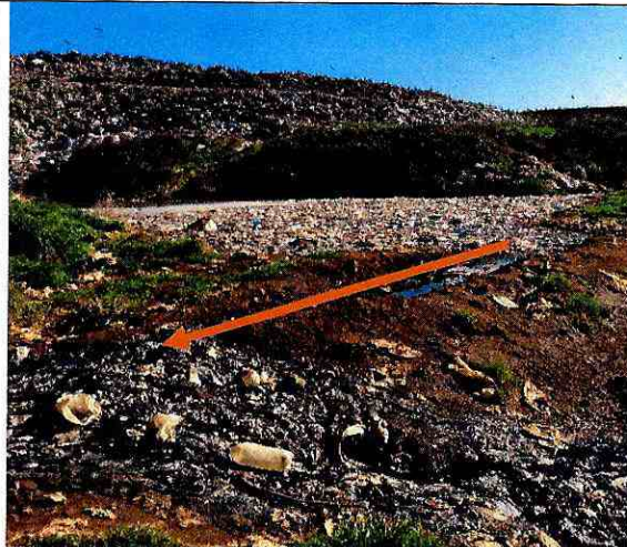
Fotografía N°11: Se observa el rebalse de los líquidos lixiviados desde la laguna aguas abajo hacia el sector norte del vertedero.
