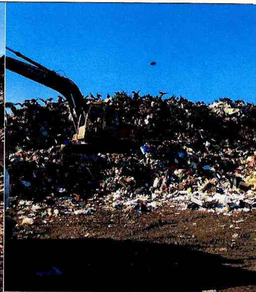
Fotografía N°6: Se observa excavadora (una sola) operando en la acomodación de los residuos en una tercera terraza de trabajo.
