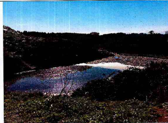
Fotografía N°10: Laguna de lixiviados en el sector Este del vertedero, de aprox. 300 mts 2
