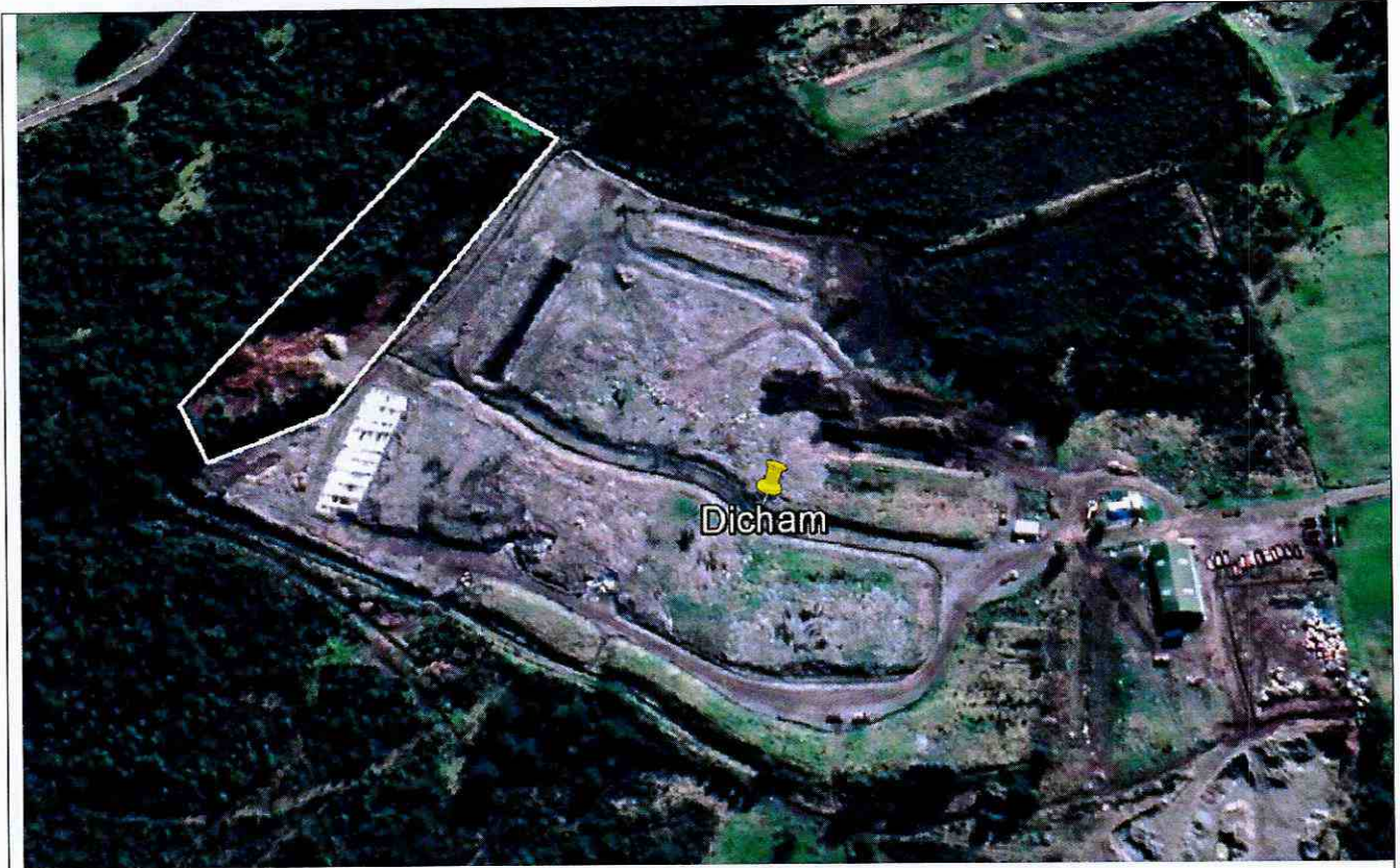
Imagen N° : En color blanco polígono lado oeste del vertedero, donde se acumularon líquidos lixiviados.
