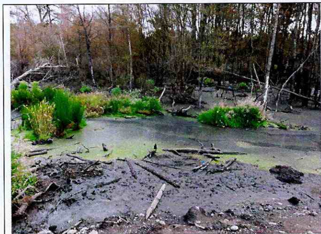
Fotografía N° 1: Acumulación de líquidos lixiviados lado oeste del vertedero. Se aprecia en el fondo el bosque de coigues.
