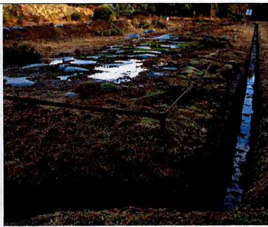
**Fotografía 5:** Sistema de canalización de aguas lluvias de zanjas al inicio del predio.
