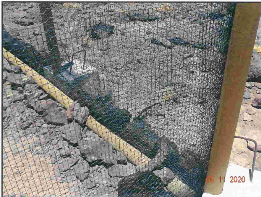
Figura 9. Acercamiento a las medidas preventivas antitrepanamiento de las mallas que forman la pared de los sitios de relocalización.
