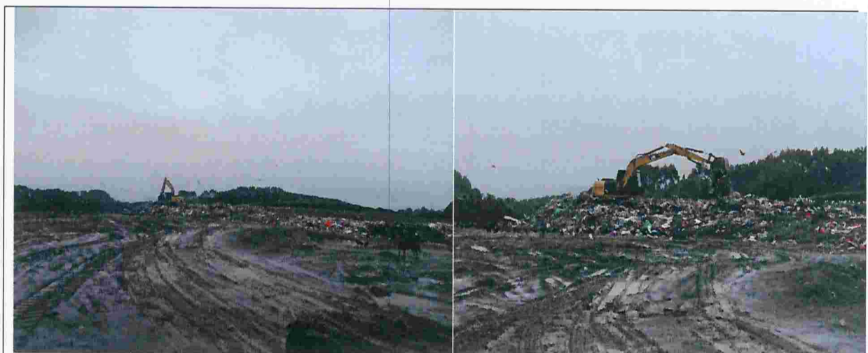
Fotografía N°1: Se constata la presencia de residuos dispersos fuera del frente de trabajo, y material de Fotografía N°2: Se constata la existencia de un frente de trabajo activo que forma parte del quinto
