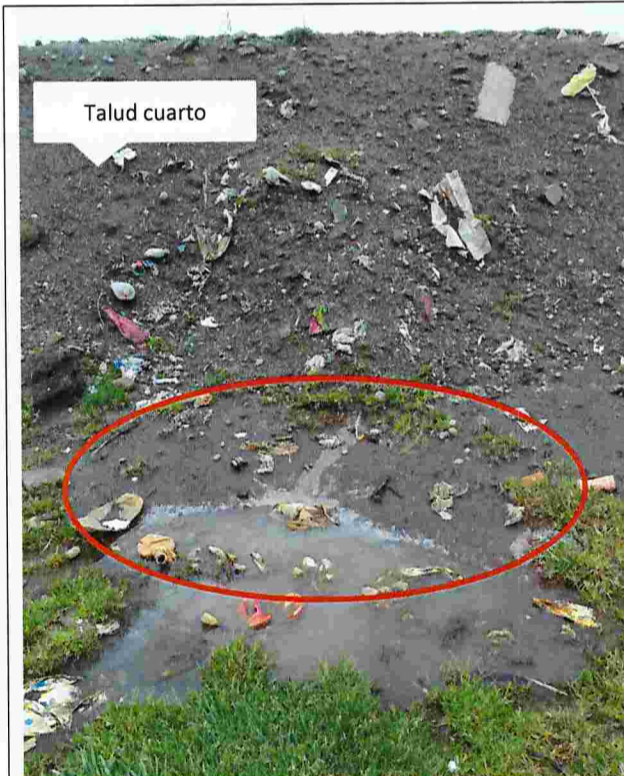
Fotografía N°5: Se constata afloramiento de lixiviados en base del talud del cuarto nivel de la
