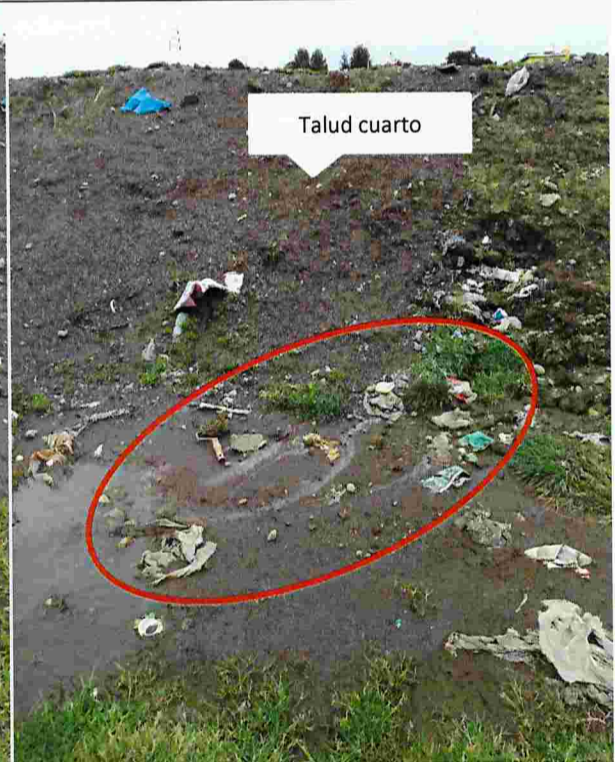
Fotografía N°6: Se constata afloramiento de lixiviados en base del talud del cuarto nivel de la
