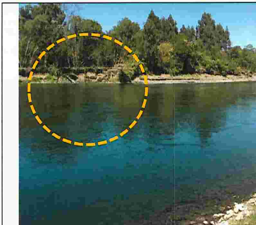
Imagen N° 11: Vista de ribera aledaña a bocatoma de piscicultura El Copihue, específicamente aguas arriba del pretil mostrando socavón (Fuente: Inspección 22 de octubre de 2020).
