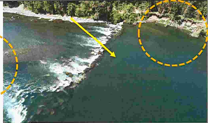
Imagen N° 10: Vista del pretil transversal. Se constata que en la ribera aledaña y previo al pretil, que el borde del río se encuentra en proceso de desmoronamiento (Fuente: Inspección 22 de octubre de 2020).
