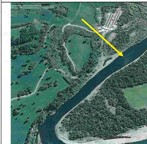
Imagen N° 13: Imagen satelital del año 2016, mostrando zona aguas arriba de la bocatoma de Piscicultura El Copihue, donde se observa zona con variación en el flujo del cauce (flecha), dada la instalación de maxisacos (Fuente: Google Earth).
