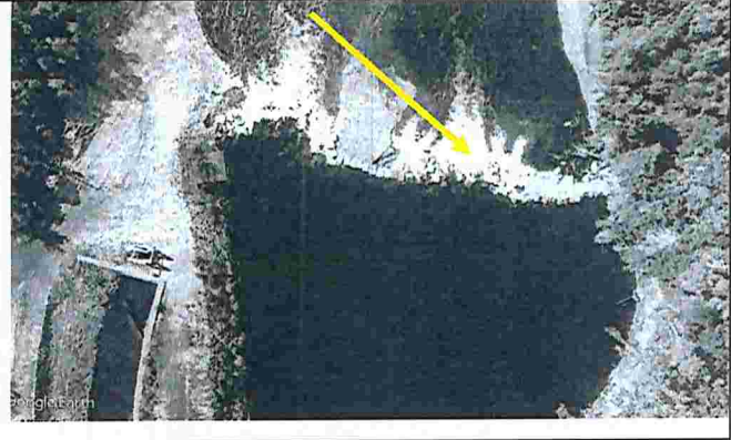
Imagen N° 6: Vista aérea del pretil transversal al río Rahue (Fuente: Expediente DGA FO-1002-52, 30 de abril de 2020).
