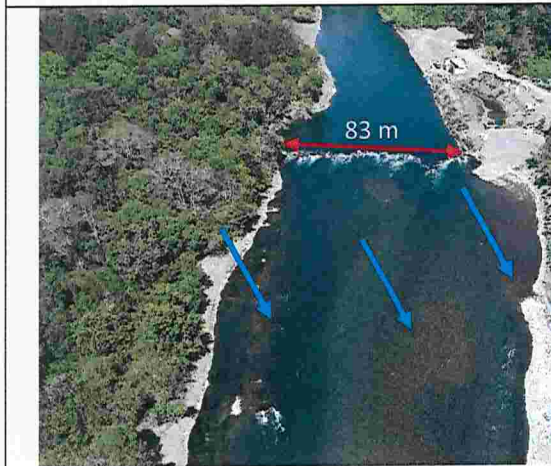
Imagen N° 7: Imagen aérea del pretil transversal de 83 m de longitud aproximada. Se pueden visualizar zonas de agradación de sedimento (flechas azules), aguas abajo de dicha obra (Fuente: Inspección 22 de octubre de 2020).
