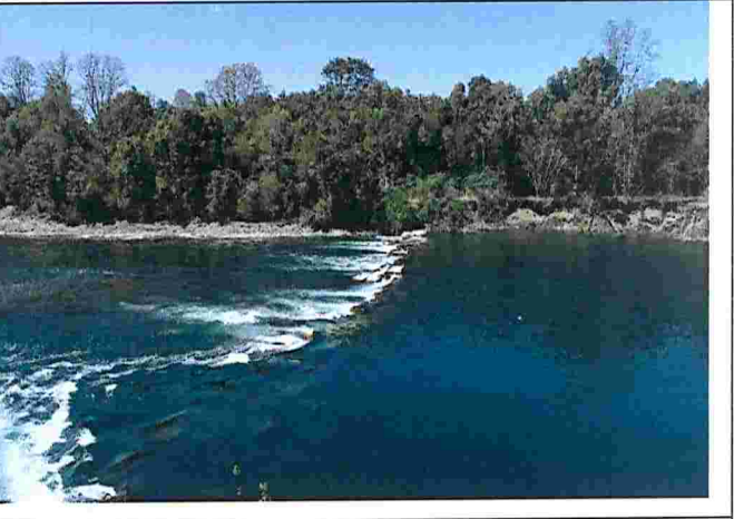
Imagen N° 8: Vista del pretil transversal. Se puede visualizar el cambio en la velocidad del flujo de agua y con ello, una zona de agua peraltada, generando una diferencia de la altura del pelo de agua (Fuente: Inspección 22 de octubre de 2020).
