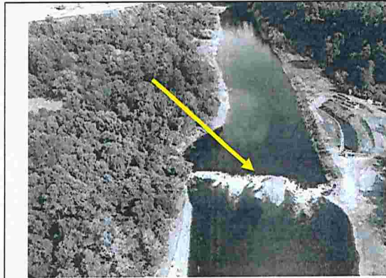
Imagen N° 5: Imagen aérea del pretil (Fuente: Expediente DGA FO-1002-52, 30 de abril de 2020).
