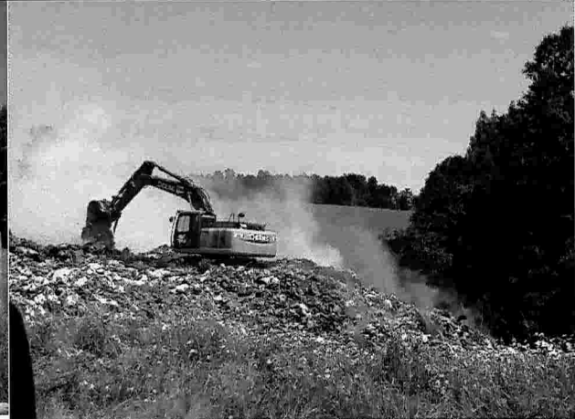
Fotografía N°2: Excavadora de propiedad municipal, se encuentra trabajando para amagar focos en la zona norte del vertedero.
