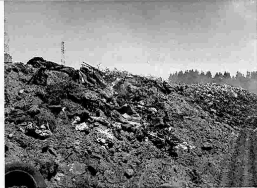
Fotografía N°4: Se observan residuos en la orilla del camino construido por la excavadora, sobre los cuales la maquinaria depositó material de cobertura con el fin de amagar un punto de emanación de humo.
