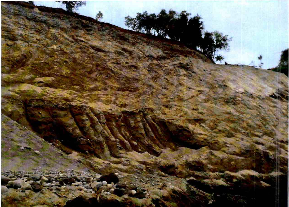
Fotografía 4. Se observa la intervención efectuada por la maquinaria que ejecuta los trabajos de camino interior; considerar la gradiente del corte efectuado en el terreno (24-12-2020).
