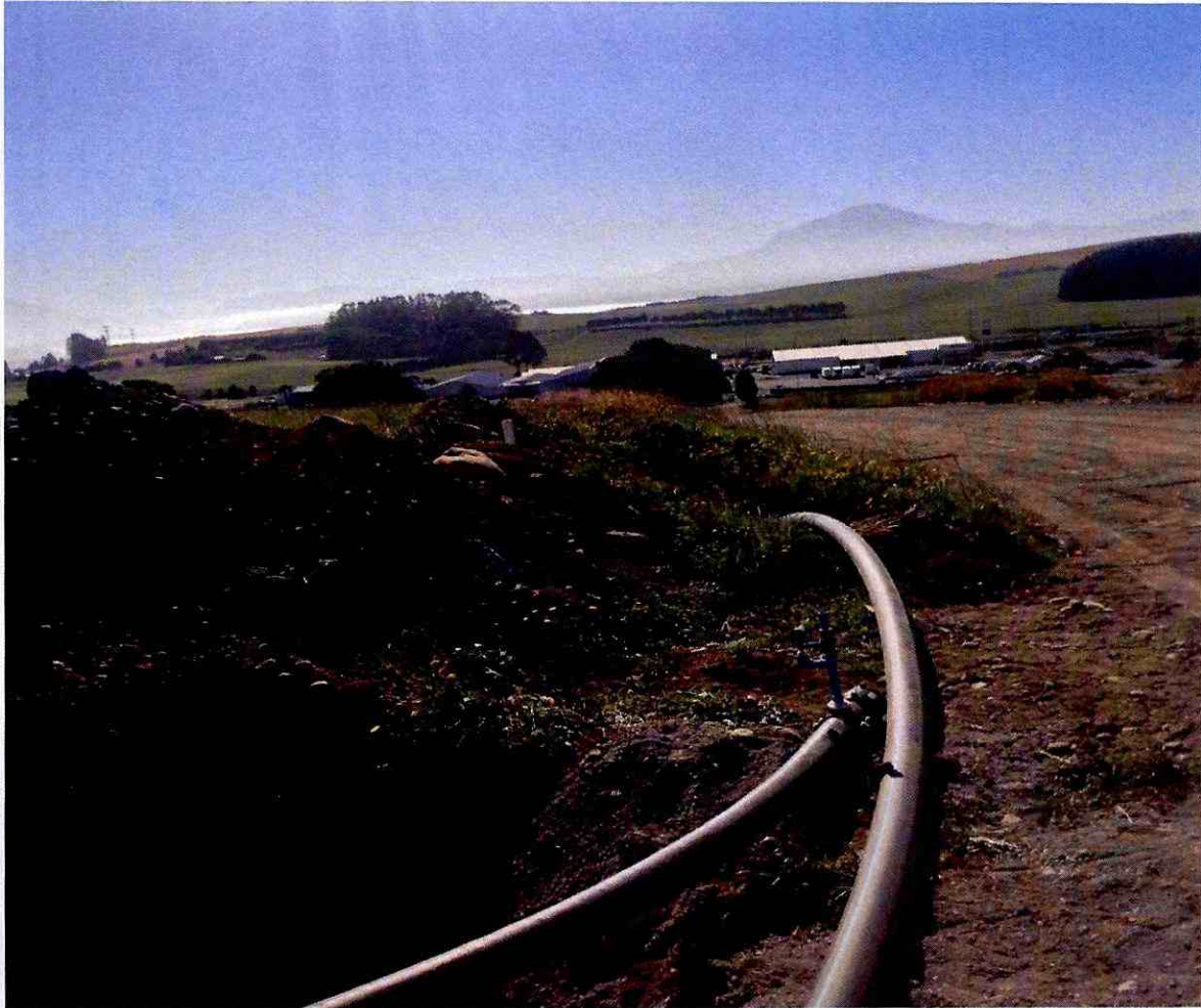
Fotografía 9. Instalación de tuberías para el abastecimiento de agua del loteo Alto Maullín (05-02-2021).
