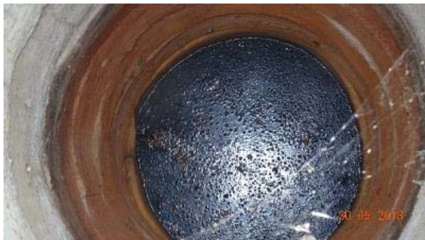
Imagen N°3: Agua de pozo contaminada
