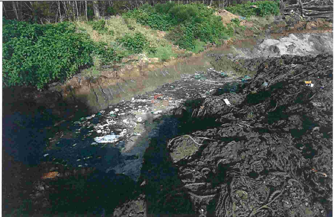
Fotografía N°6: Se constata existencia de pozo de acumulación de líquido de tonalidad verdosa, mezclado con residuos sólidos de tipo domiciliario, y tarro de pintura. Se observan redes enterradas alrededor.
