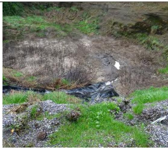
**Fotografía N°8:** Se observa pozo Norte de absorción de aguas lluvias. Se constata canalización con vertimiento de líquido oscuro proveniente de pila Noroeste.
