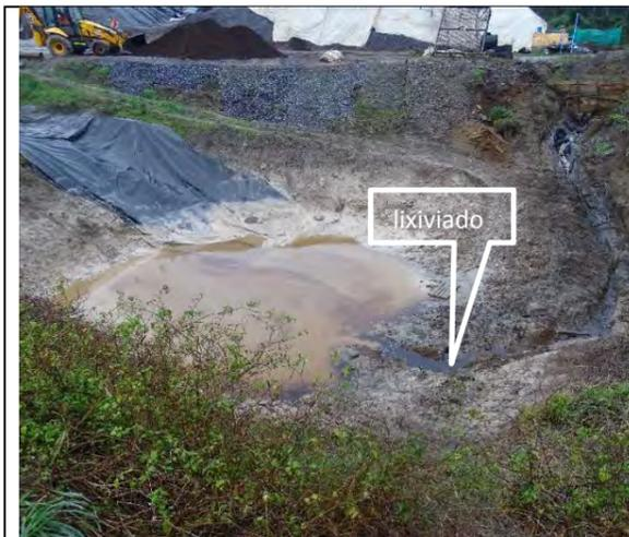
**Fotografía N°7:** Se observa pozo Sur de absorción de aguas lluvias. Se constata líquido oscuro (lixiviado) que llega al pozo.
