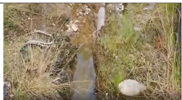
Fotografía N°7: Ril que se encuentra en el costado este del tercer estanque.
