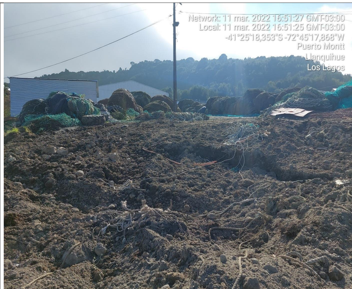
Fotografía N°1: Zona de disposición de lodos, cabos y residuos varios. La imagen permite observar el movimiento de tierra reciente, material no compactado.
