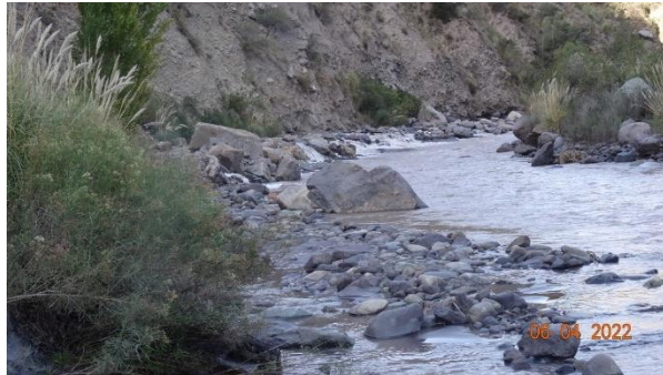
Fotografía 1: obra temporal en bocatoma El Manzano
