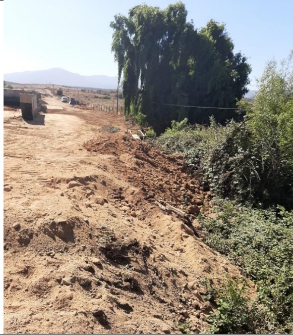
Fotografía 7. (Fuente: Inspección ambiental SMA 14-12-2021)
