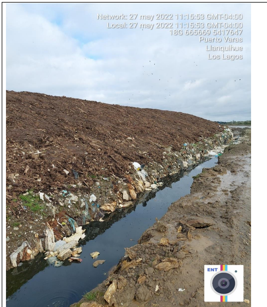
Fotografía N°4: cuneta del lado norte del alveolo 1, se constata agua lluvia mezclada con lixiviados y residuos.
