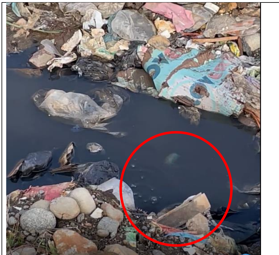
Fotografía N°6: cuneta del lado Sur del alveolo 1, se constata agua lluvia mezclada con lixiviados y residuos.
