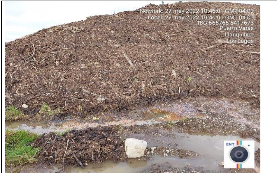
Fotografía N°3: se observa en la esquina del lado Norte con el este del alveolo 1, escurrimiento de lixiviado.
