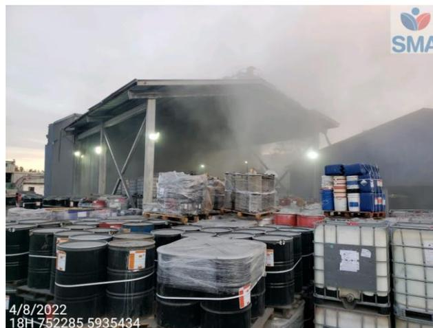
Foto 3 Estación 1 CITA Acopio de Respel intemperie, ausencia de pretil de seguridad y nula impermeabilización basal.
