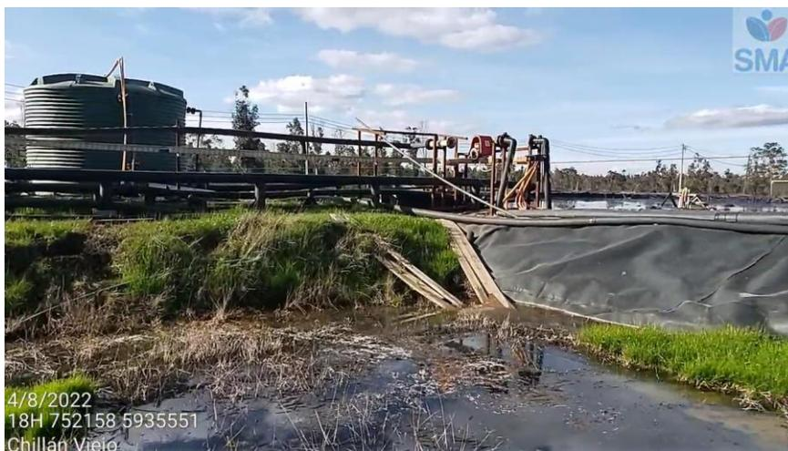
Foto 19 Estación 2 Sector norte zona de disposición CITA en desarrollo de zanja abierta de verificación de filtraciones
