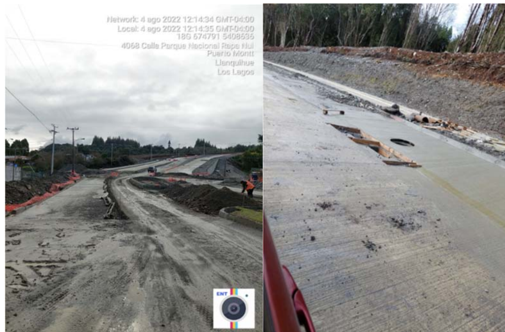
Imagen N°9: Trabajos para el manejo de aguas lluvias en “Avenida El Bosque”, lado oriente
