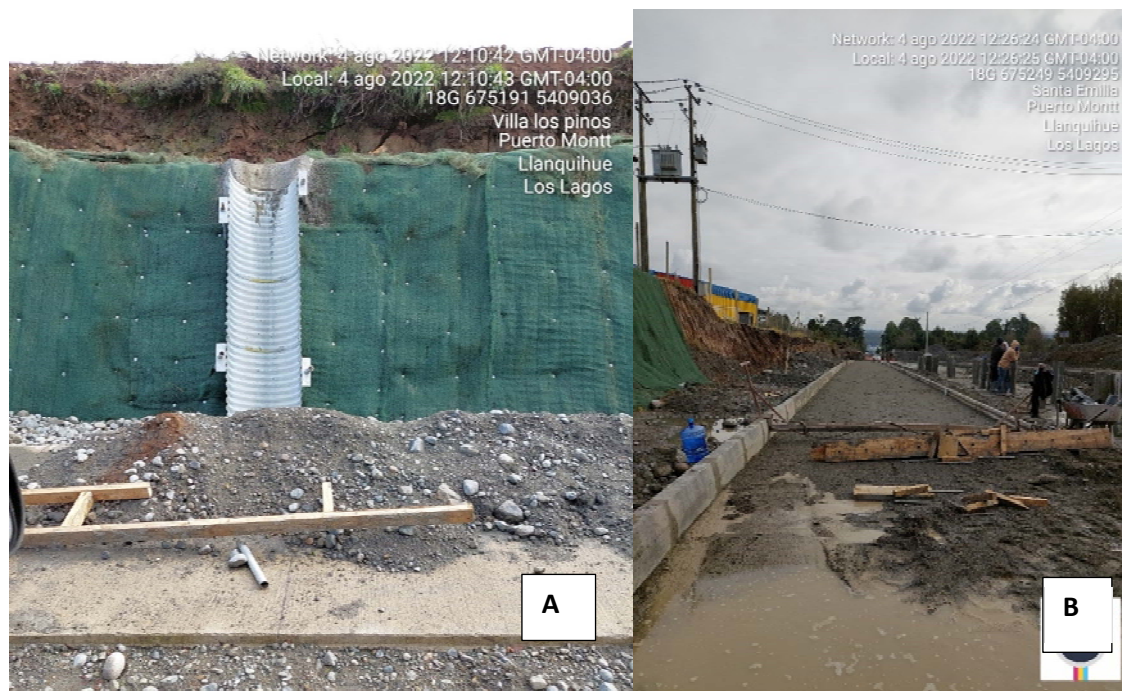
Imagen N°10: A) Canaletas para aguas lluvias en “Avenida El Bosque”, sector poniente; B) Trabajos en “Avenida El Bosque”, que conecta a “Avenida Fourcade”
